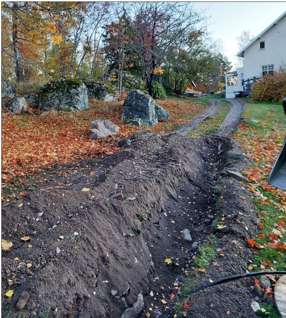
Figur 4. Schaktning pågår. Schaktet sett från söder.
