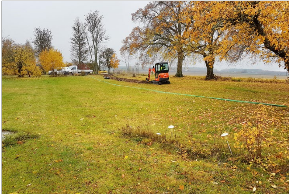
Figur 18. Schaktning med liten tomtgrävare vid schakt 117 där rester efter två husgrunder påträffades. I gräsmattan i bild hade en jordvärmekabel grävts ned. Den grävdes även sönder i samband med arbetet, till fastighetsägarens förtret.
