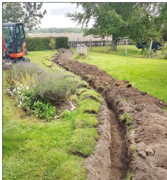
Figur 7. Schakt 104 som endast berörde matjordslager. Foto från väster.
