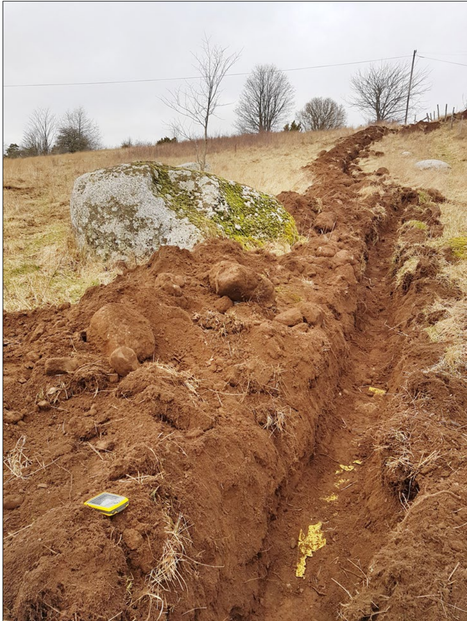
Figur 30. Schakt 139 grävdes till större delen i ett äldre kabelschakt. I bild ses den äldre kabelns gula skyddsband. Foto från sydöst.
