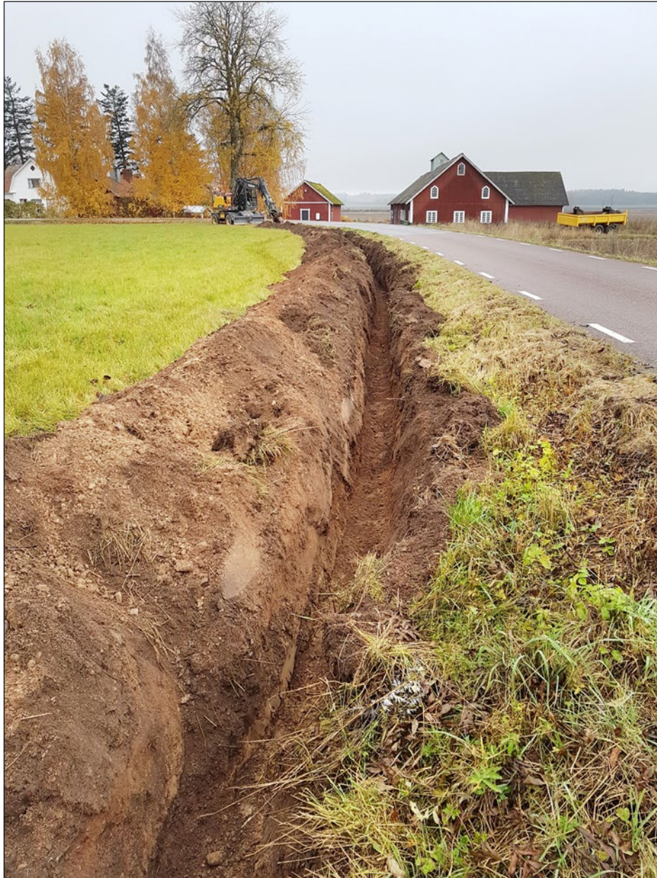
Figur 17. Schaktning vid norra delen av schakt 118 som grävdes på platsen för den gamla Västergården. Foto från öster.
