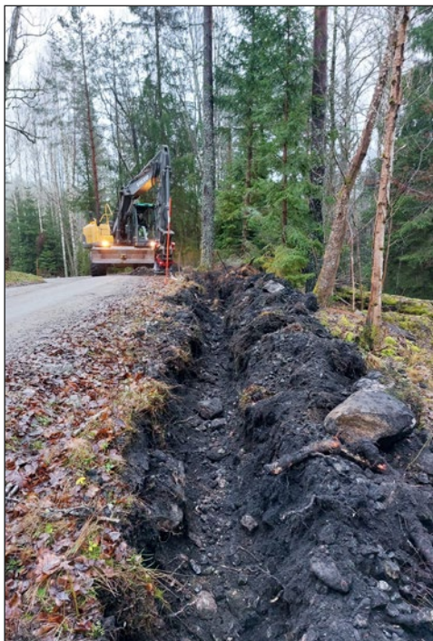
Figur 3. Schakt 200. Foto från nordväst.
