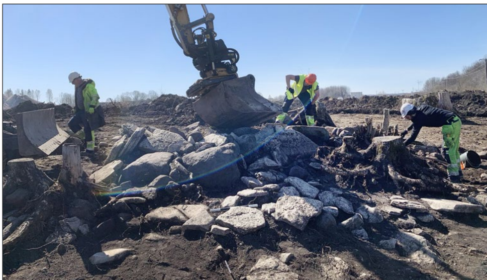
Figur 22. Arbetsbild som visar kantkedjan A3333 och stenpackningen A3544. Foto från norr.
