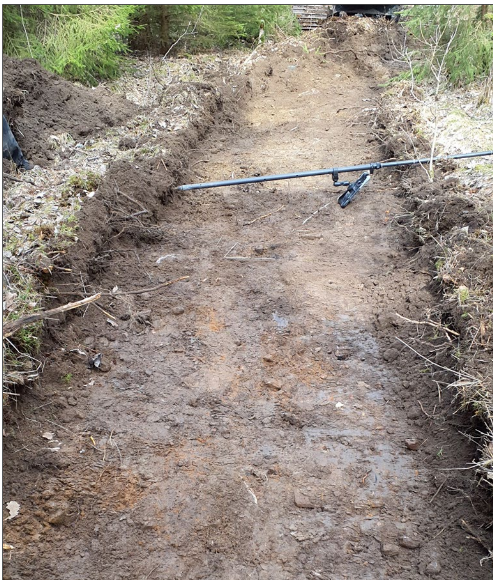
Figur 9. Lager A1129 i schakt S120. Foto från norr.
