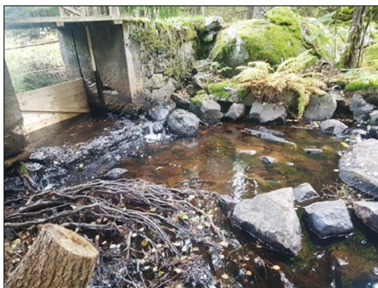
Figur 11 (till höger). Dammöppningen vid dammvall L2021:170 sedd från väster. I samband med åtgärden blockerades öppningen och leddes om till en nordlig strömfåra. Den lokala åtgärden bestod i att fylla ut med naturgrus i nivå med utskovet och därmed minska fallhöjden.
