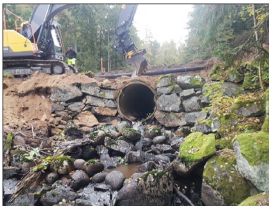
Figur 5. Vägtrumman sedd från sydväst vid nedströmssidan, innan åtgärder sattes in. Nedanför vägtrummans utlopp är ett högt och stenigt fall.
