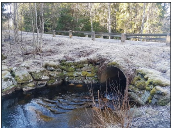
Figur 4. Vägtrumman sedd från nordöst på uppströmssidan, innan åtgärd. Stödmurar är anlagda vid trummans sidor.
