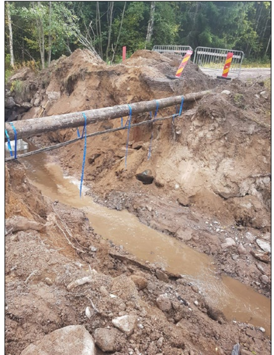
Figur 8. Schakt 1 sett från norr. Vägtrumman har tagits bort och inom schaktet påträffades enbart utfyllda massor av morängrus och sprängsten.
