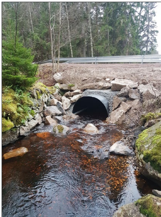
Figur 9. Den nya vägtrumman sedd från nordöst på uppströmssidan. Närmast trumman har befintligt grusmaterial nyttjats.
