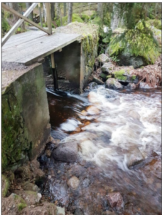
Figur 12. Dammöppningen vid dammvall L2021:170 sedd från nordväst. Grus och stenar har anlagts emot dammöppningens utskov i syfte att minska fallhöjden.
