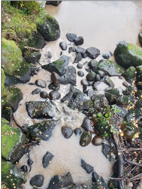
Figur 7. Utloppet sett från öster. Det är belamrat med sten. Dock kunde inga konstruktioner efter tidigare kvarn påträffas i form av rester av bevarad kallmurning.
