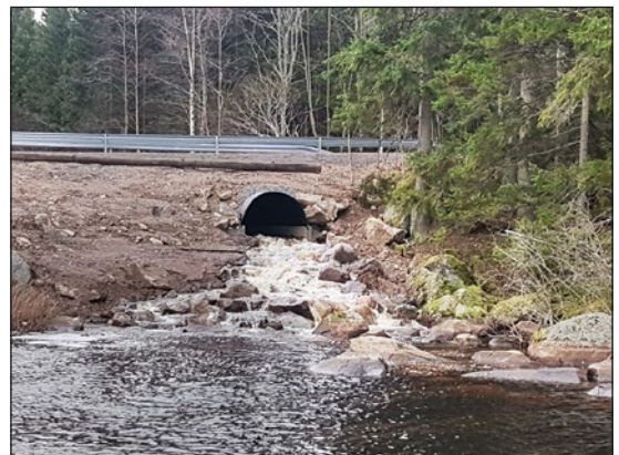
Figur 10. Den nya vägtrumman sedd från väster på nedströmssidan. Fallet på nedströmssidan har förlängts och därmed underlättat för vandring av fisk uppströms Holmsjöbäcken.
