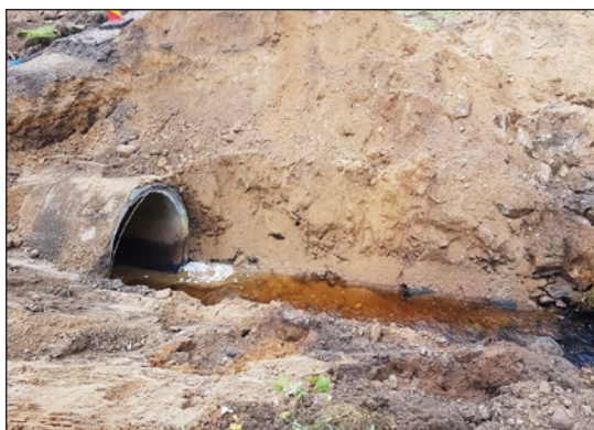
Figur 5. Vägtrumman sedd från sydväst vid nedströmssidan, innan åtgärder sattes in. Nedanför vägtrummans utlopp är ett högt och stenigt fall.
