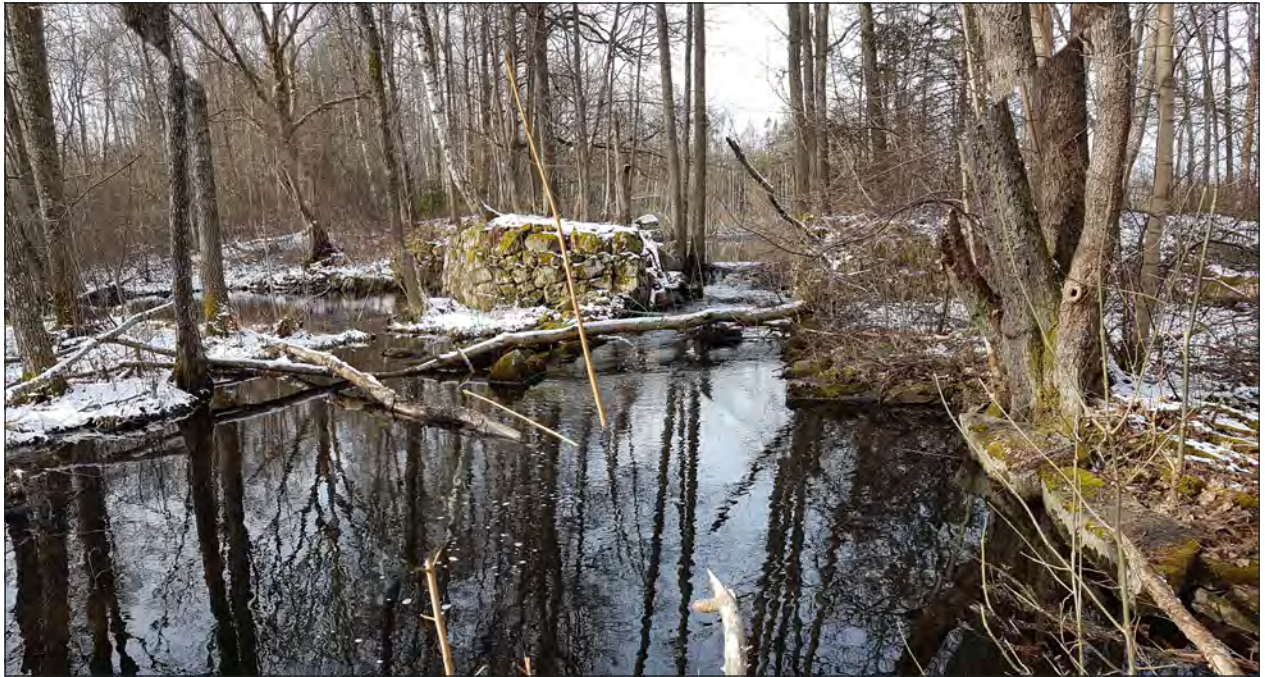
Figur 46. Vy över kvarndammens norra inlopp till kvarnen. Delar av kvarnbyggnadens husgrund är synlig till höger i bild vid åkanten i form av rektangulära stenblock. Till vänster om dammöppningen syns den kallmurade mittpelaren. Foto från öst.
