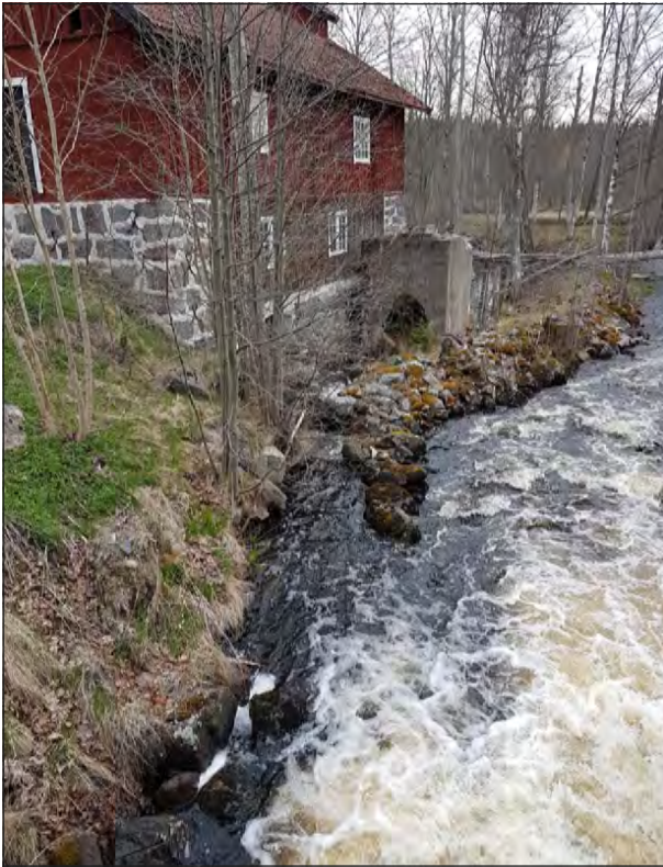
Figur 61. Kvarnrännan längs åns norra sida. Det stensatta fundamentet utgör möjligen rester efter den äldre kvarnen. Foto från väst.
