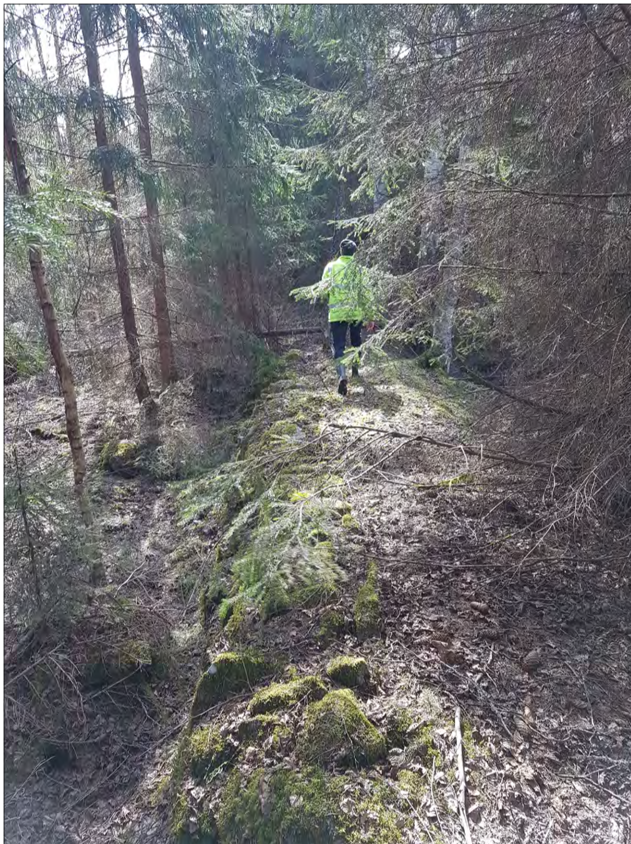
Figur 78. Skepphulta dammvall var jordfylld på insidan och stenbäklädd på utsidan. Foto från nordväst.
