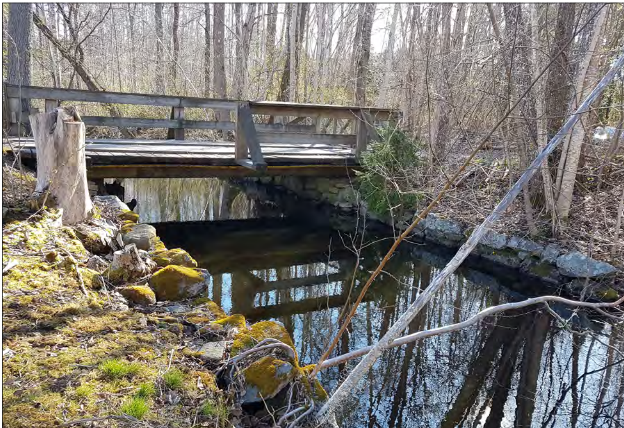
Figur 37. Foto med den stensatta rännan, sydöst om slussöppningen. En tidigare dammlucka har reglerat vattentillflödet vid platsen. Foto från nordväst.
