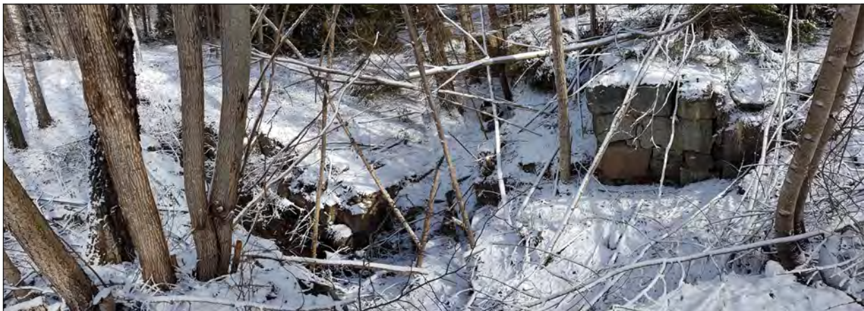
Figur 45. Till höger i bild syns det nordvästra hörnet av masugnsbyggnaden med utloppsränna som leder ned till ån. Foto från sydväst.
