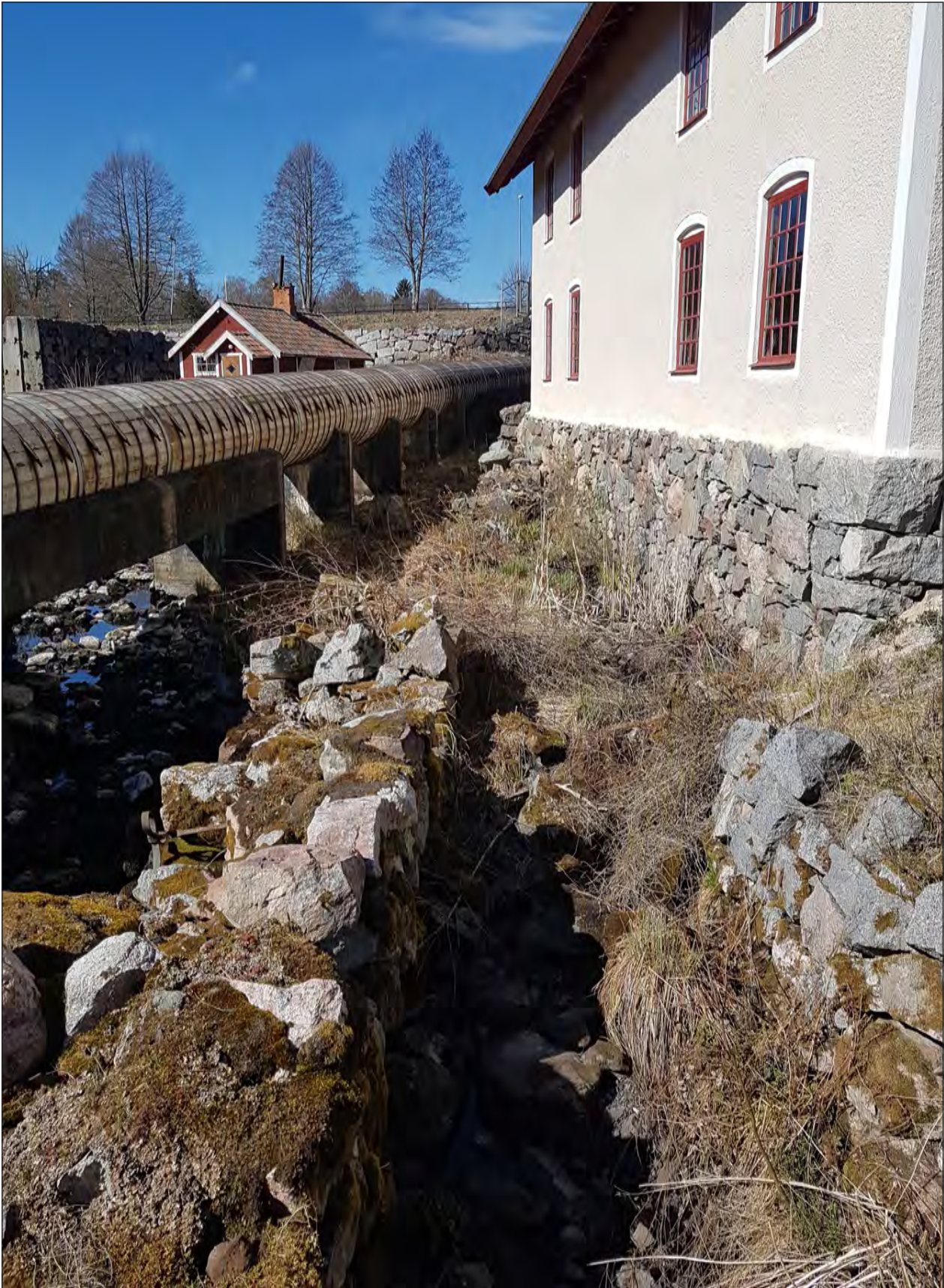
Figur 50. I lämningens nordöstra hörn finns en hjulgrav bestående av ett fundament och stensatt strandmur. Hjulgraven ligger i linje med fundamentet som påträffas strax öster om den befintliga damm- öppningen, se bild 48.
