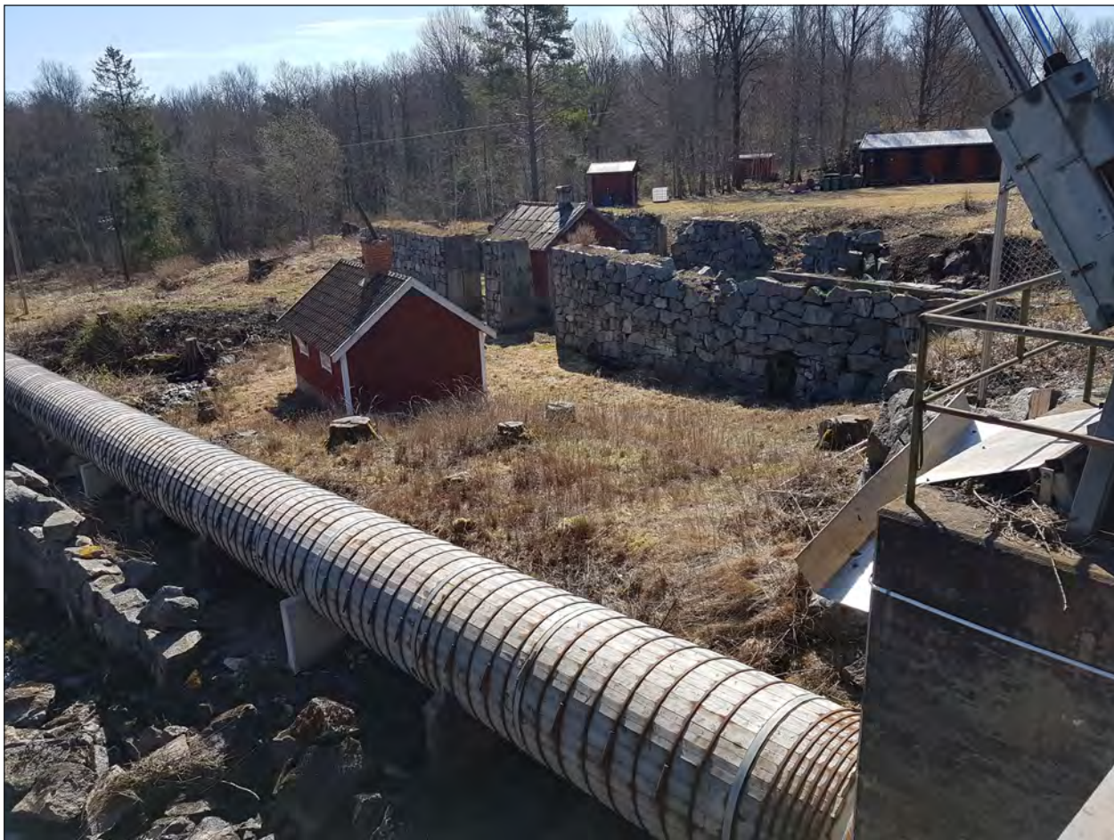
Figur 48. Vy över hammarområde, objekt 9 sett från nordväst. Till vänster i bild under tuben syns en del av ett kallmurat fundament. I bildens högra del syns ruinen efter hammarsmedjan.
