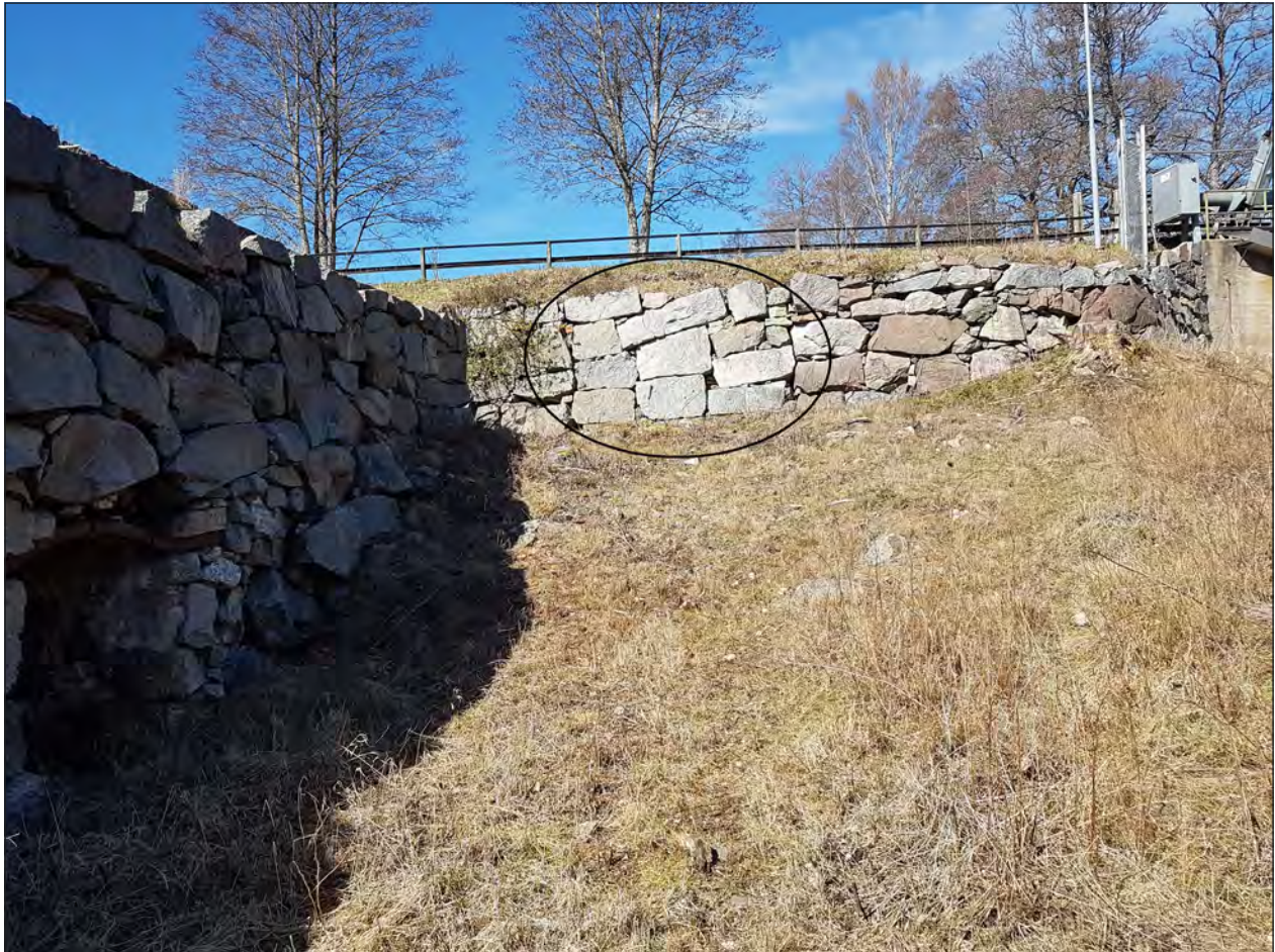
Figur 49. Dammvallen sedd från sydväst invid hammarsmedjegrunnen. Den svarta cirkeln markerar läge för en tidigare dammlucka som blivit igensatt.
