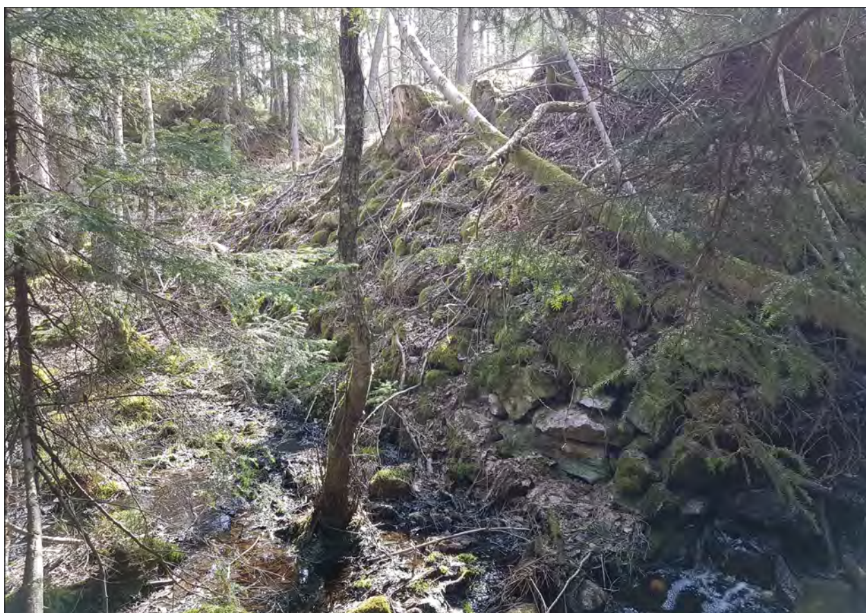
Figur 74. Niagaradammens bas sedd från nedströms sida. Vallen består av jord och stenbeklädnad. Foto från nordväst.
