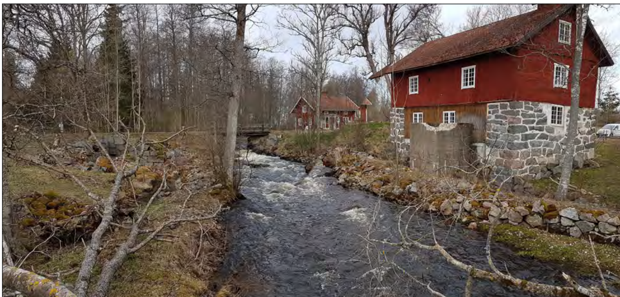
Figur 60. Vy över lämningsområdet (objekt 15) i Lagmansbacka. Till vänster i bild syns del av såggrund- den. Till höger syns den stående kvarnbyggnaden från 1855 med utvändigt turbinrum i betong. Längs ån syns utrasade fundament efter såg- och kvarnränna samt stensatt fundament längs ån. Foto från öst.
