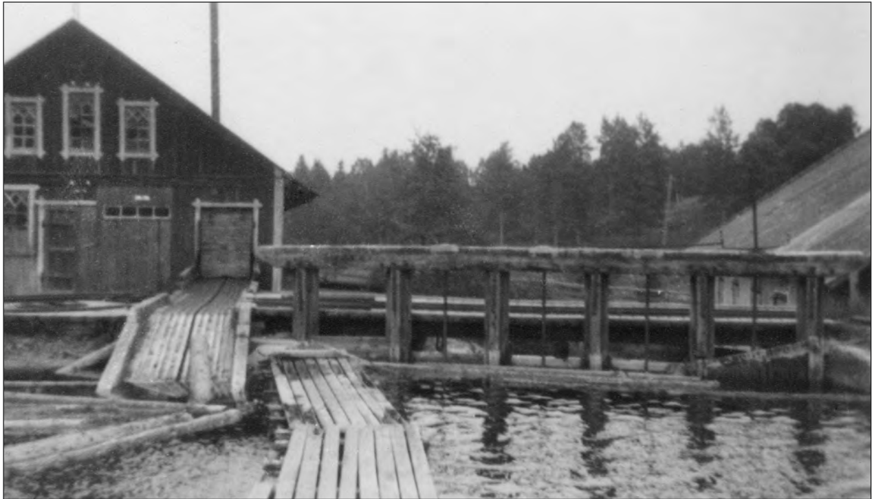
Figur 20. Foto kring år 1900 med Skogaholms sågverk vid Masungsdammen. Sågverket var beläget på norra sidan om vattendraget med masugnen i söder (Tekniska museet: TEKA0093538).
