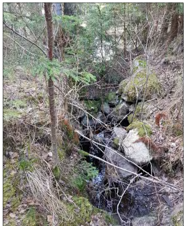
Figur 70. Öppningen vid Svarta dammens dammvall (Objekt 22) har täppts igen av utrasade stenar från tidigare kallmur. Foto från norr.
