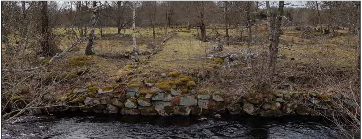
Figur 63. Del av färdväg (objekt 17) med brofäste över vattendraget. Foto från norr.
