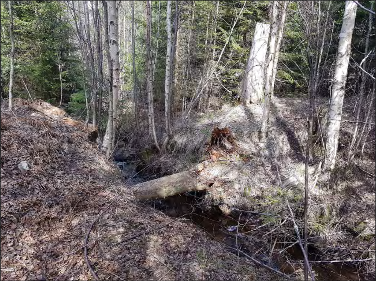
Figur 81. Dammvall (objekt 29) som anlagts vid en naturlig mosse.
