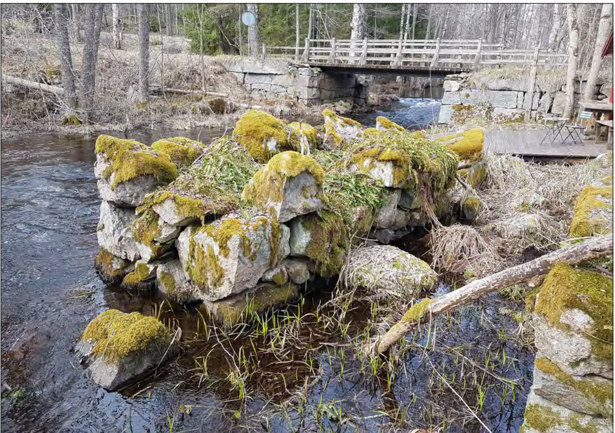
Figur 56. Del av kvarnens hjulgrav med dammvallen i bakgrunden. Foto från öst.
