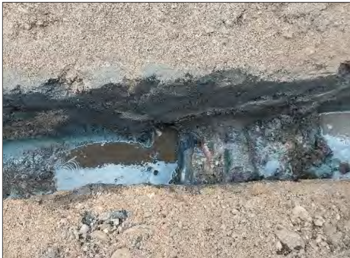
Figur 6. Trärör i botten av schaktet. Foto från öster.
