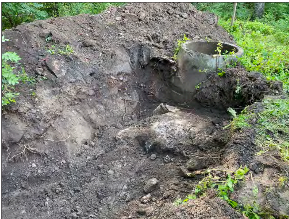
Figur 5. Schaktet grävdes fram till befintlig brunn, framför är ett fundament i betong. Foto från öster.
