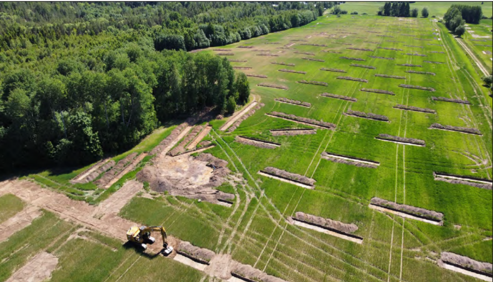
Figur 4. Igenläggning av schakt 3438 pågår. Foto från nordväst.
