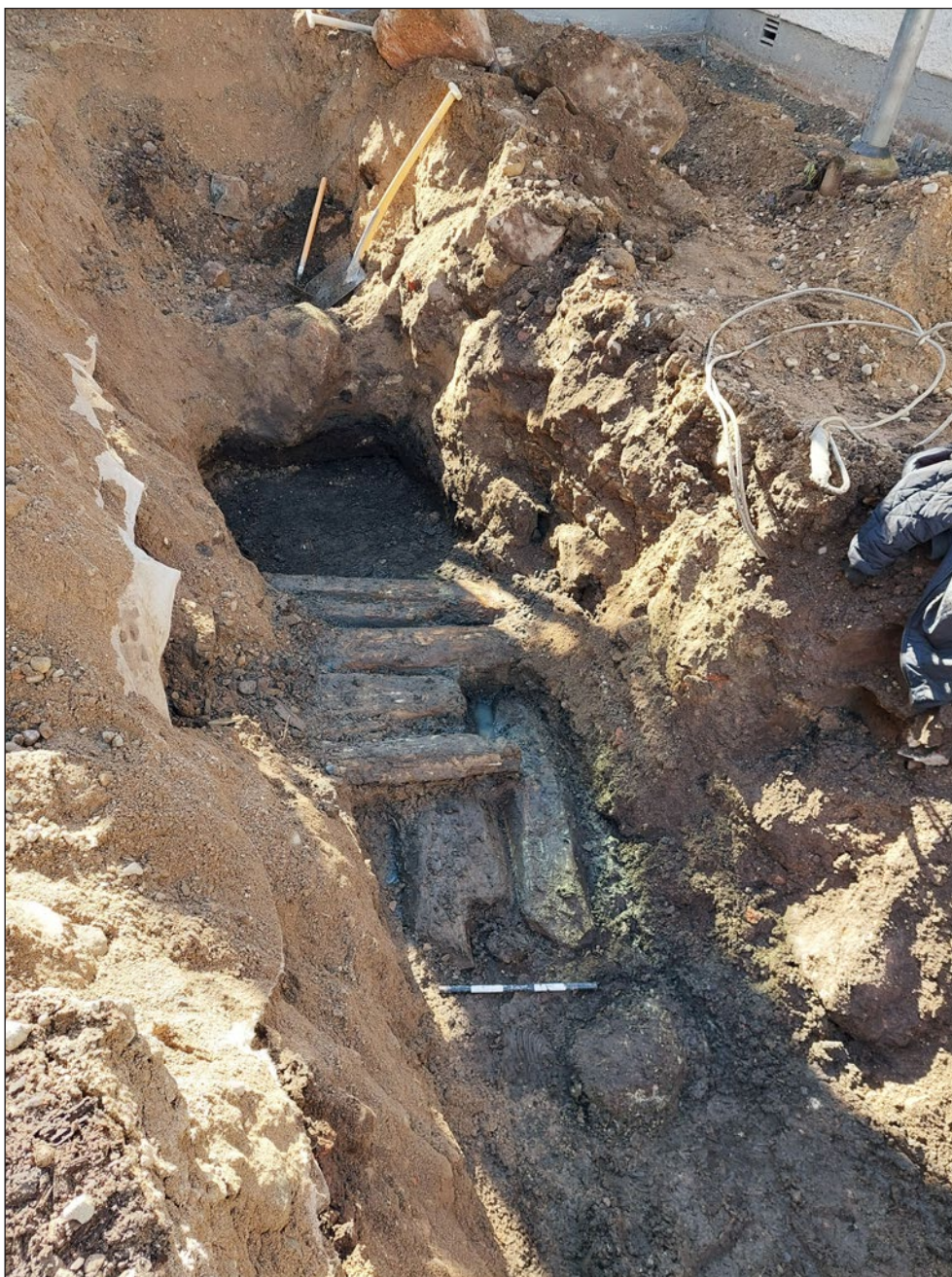
Figur 4. Schaktet fotat från norr.
