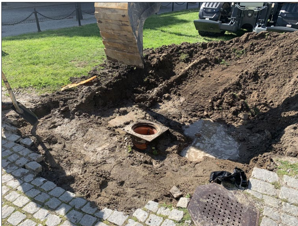
Figur 5. Schaktet (S1) efter borttagande av gatsten. De två brunnarna synliga nere i bilden. Foto från nordväst.
