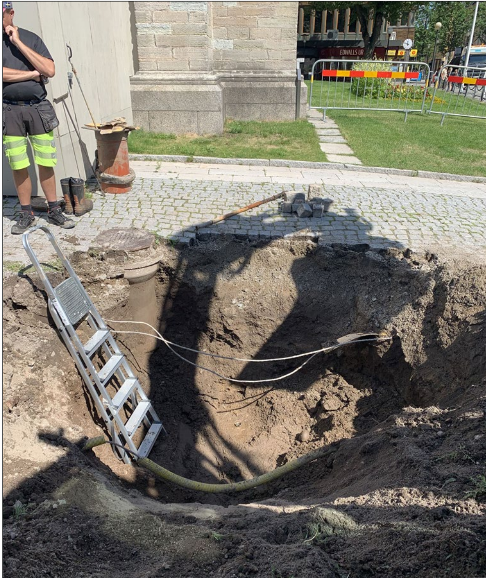
Figur 6. Schaktet (S1) med elkablar synliga centralt i bilden. Foto från söder.
