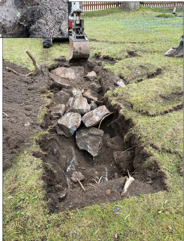
Figur 7. Fyllnadsmassorna bestående av sprängsten som framkom i stora delar av utredningsområdet. Fotot taget i utredningsområdets sydvästra del från nordöst
