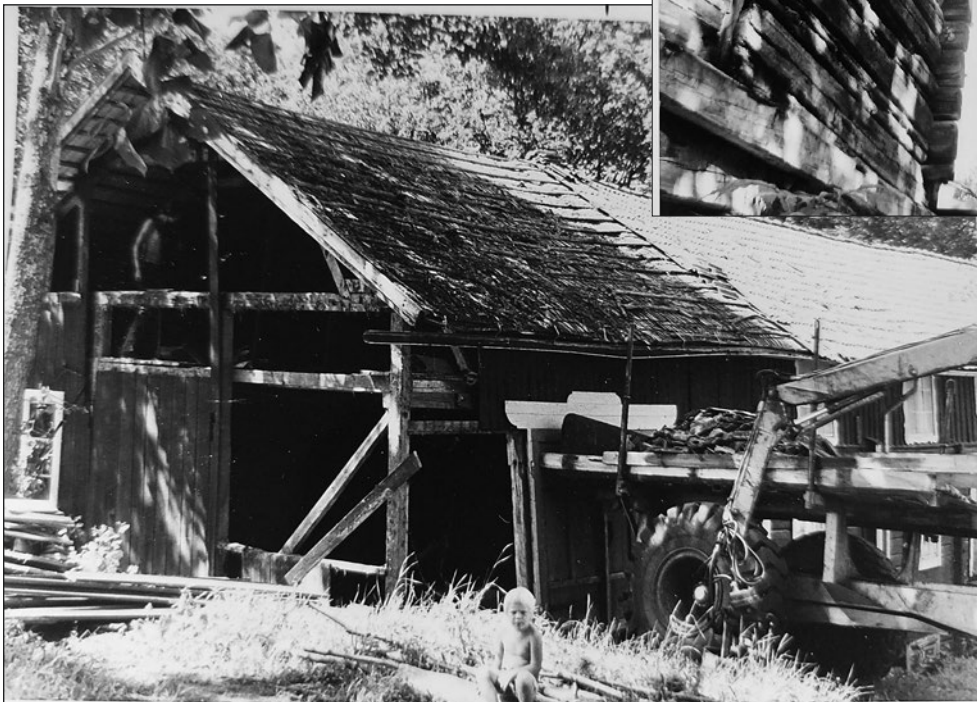
Figur 18. Kvarnens östra del, vilken inhyste raffelstoppsproduktionen, under pågående demoleringsarbete. Foto från nordväst.
