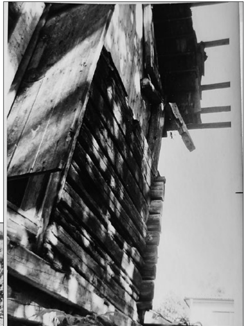
Figur 19 (till höger). Den norra änden efter att de mest fallfärdiga delarna avlägsnats och byggnadens ursprungliga gavelhorn är synligt. Foto från sydväst.
