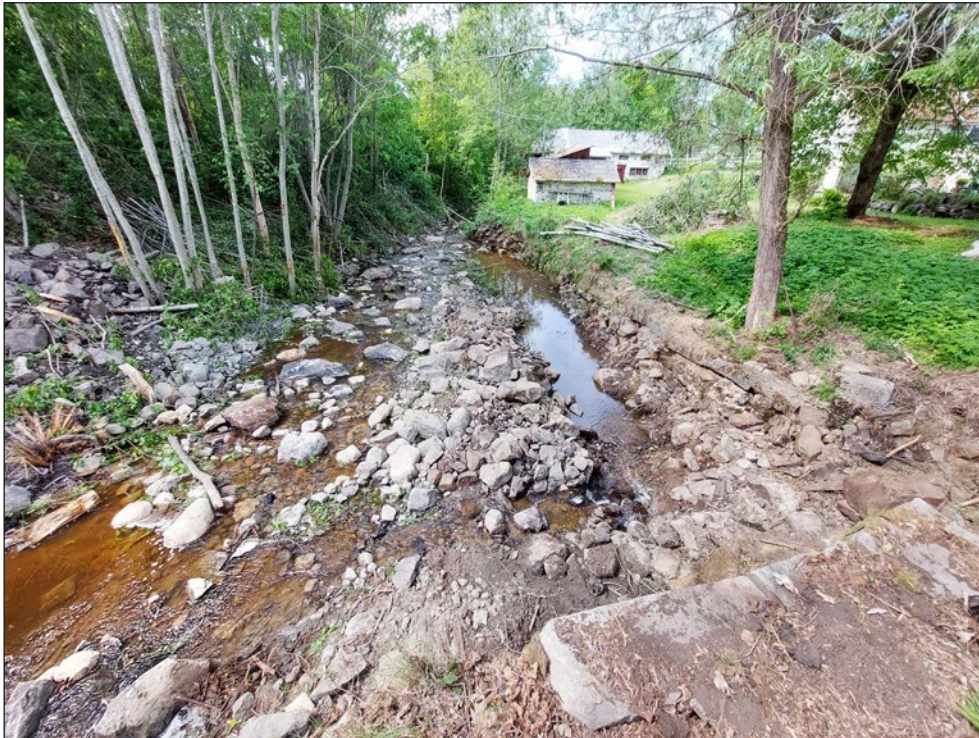
Figur 34. Hjulgraven och den södra vattenfåran direkt nedströms dammkroppen.
