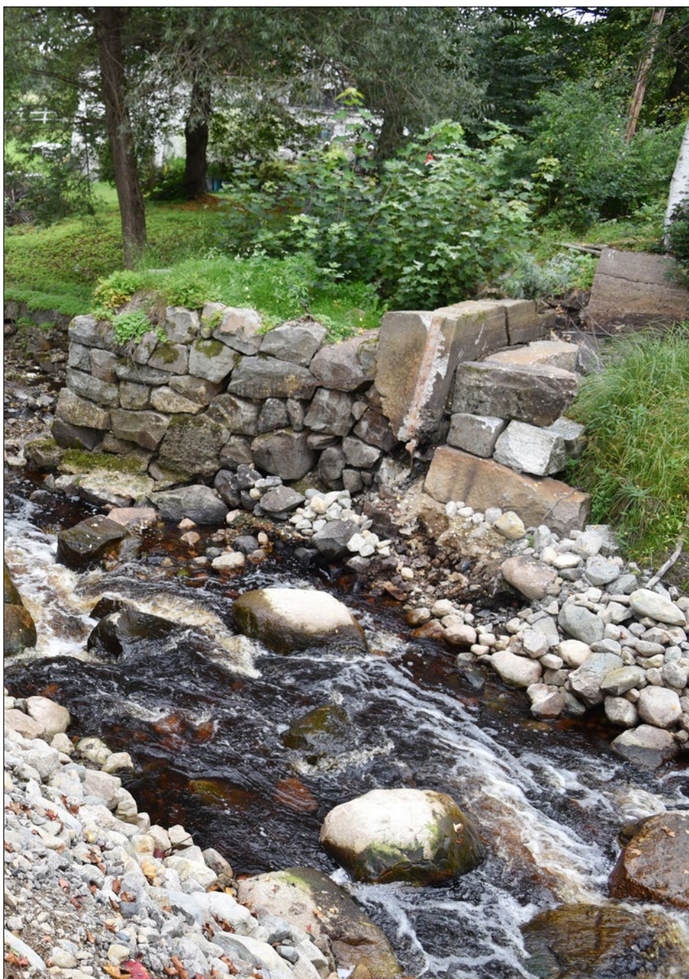
Figur 33. Mittpelaren med huggen sten på dess östra sida. från sydöst. Foto: Mats Olsson.
