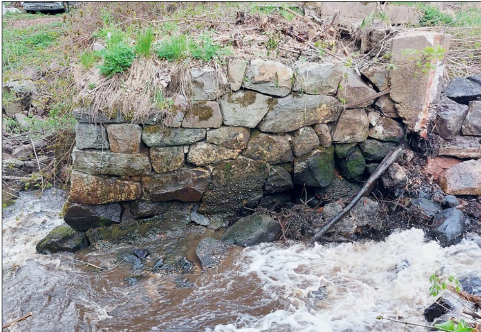
Figur 29. Mittpelaren sedd från söder. Betong med småsten i pelarens understa skikt.
