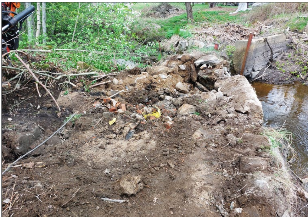
Figur 27. Det södra landfästet då betongplattan och de yttre kallmurade stenarna avlägsnats och blå leran och det spåntade trävirket påträffats.
