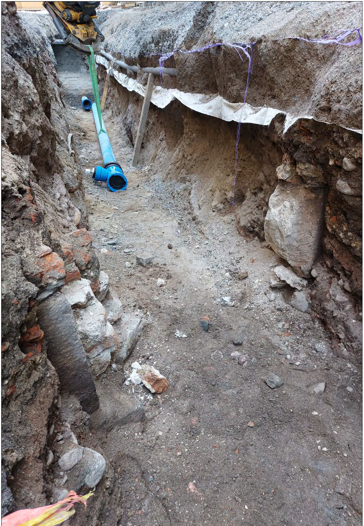
Figur 24. Mur 7, så väl framrensad som var möjligt. Foto från sydväst.
