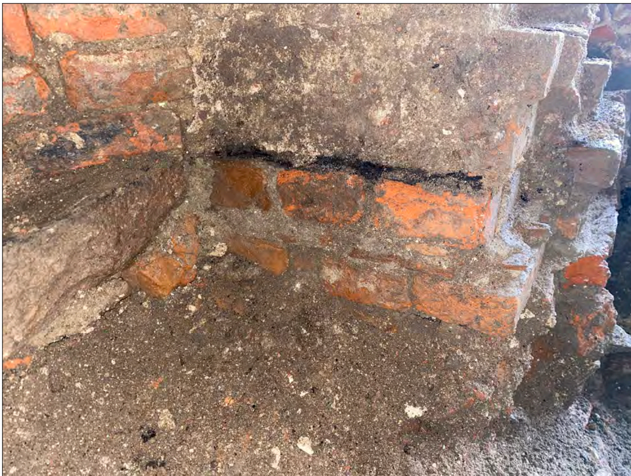
Figur 38. Insidan av mur 6b. Notera sotlinsen.
