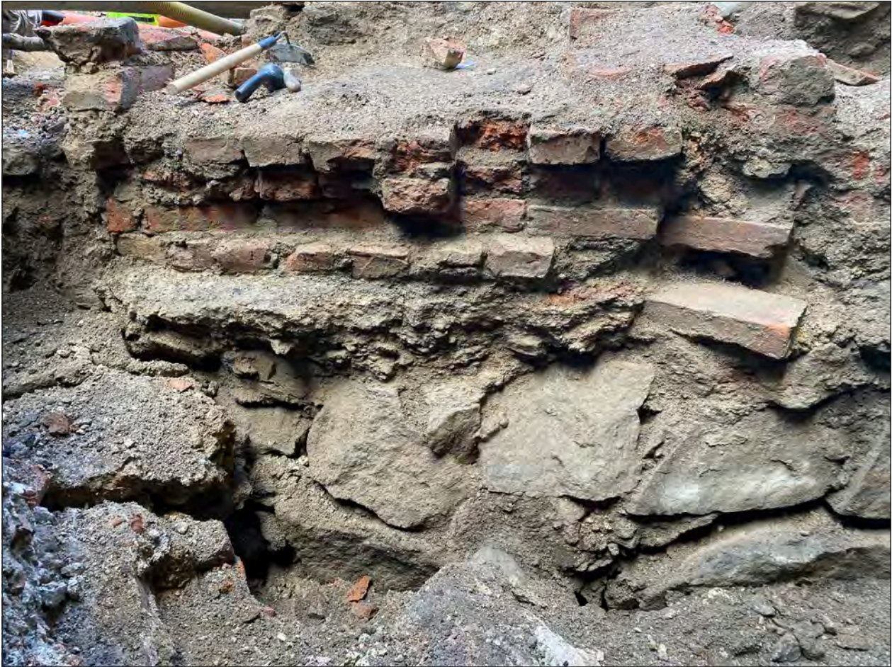
Figur 31. Insidan av mur 5, innan trappan frilades. Foto från sydväst.
