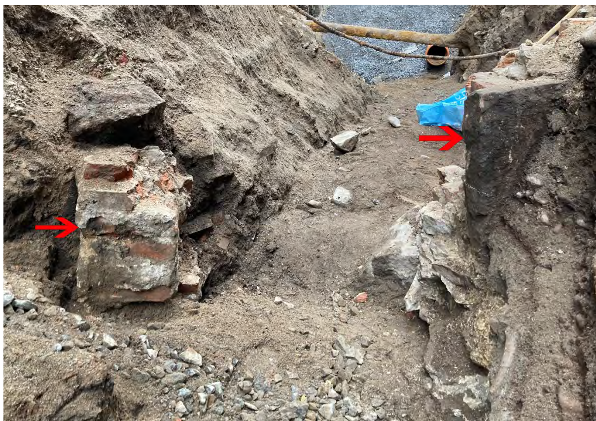
Bild. Mur 4 sedd mot nordöst. Till höger pekar pilen på en sockelsten i fasaden. Murdelen till vänster i bild har en smygsida till vänster, markerad med en pil. Foto: Anna B.
