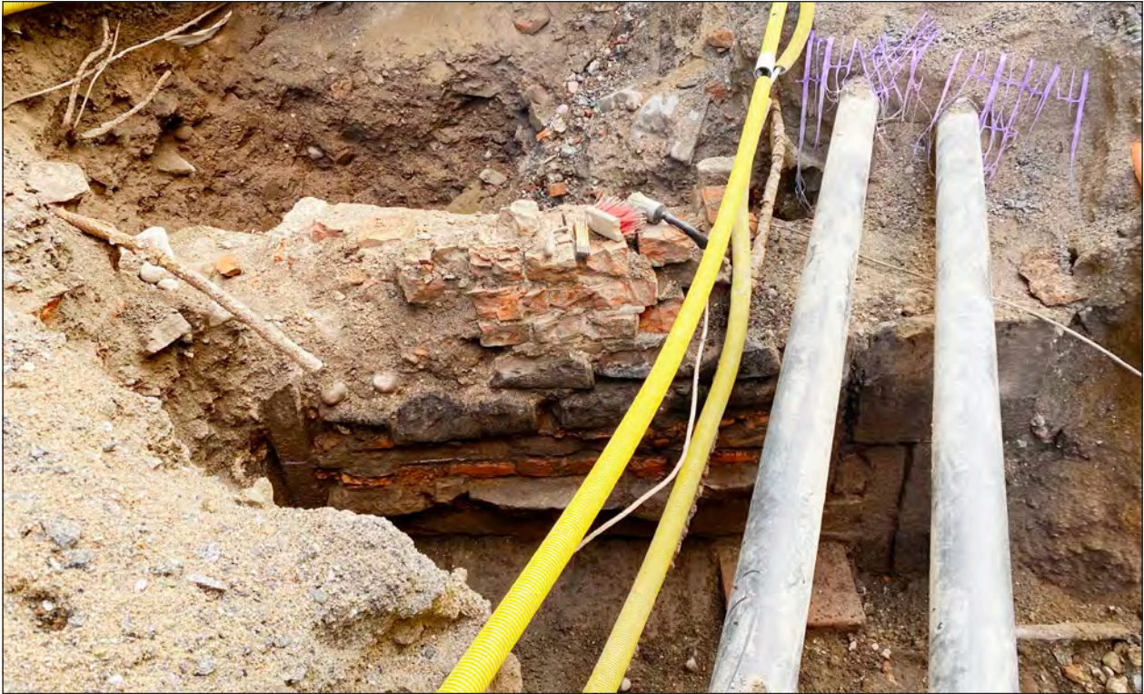
Figur 26. Mur 5 under ett virrvarr av ledningar. Foto från nordost.
