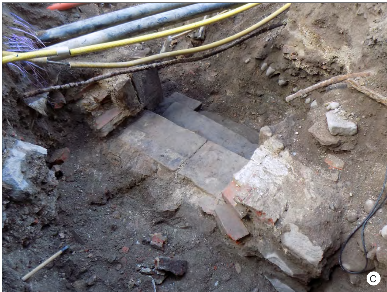
Figur 30. a) Formhuggen sockelsten i trappan. b) Sockelstenen, fasadsidan. c) Trappan sedd från schaktkanten.
