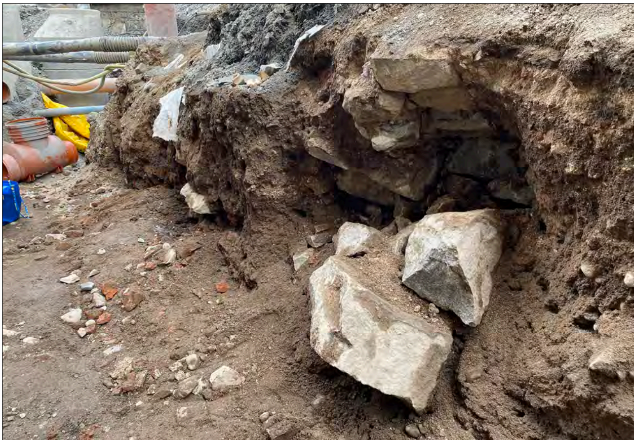
Figur 16. Schaktet längs Norstedts fasad, från väster. Mur 2 i schaktväggen till höger i bild.
