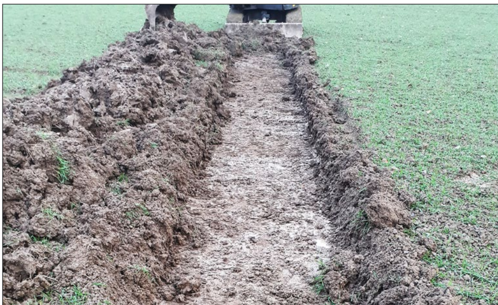
Figur 5. Schakt 217 efter avbaning av matjord. Foto från väster.
