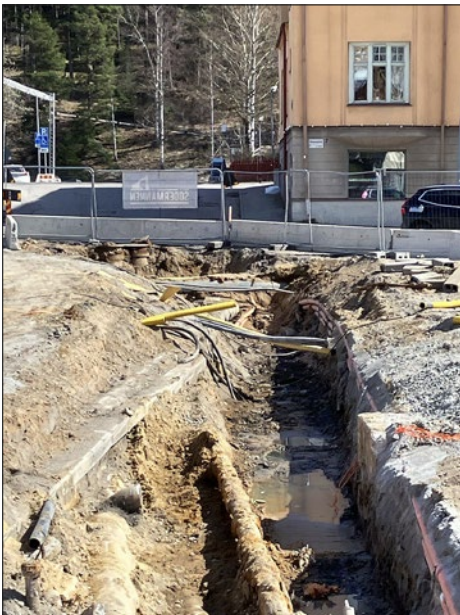
Figur 6. Den nordöstligaste delen av schaktet. Foto från väster.
