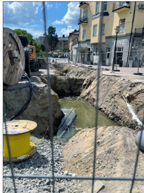
Figur 7. Del av schaktet efter att botten börjat vattenfyllas. Foto från norr.
