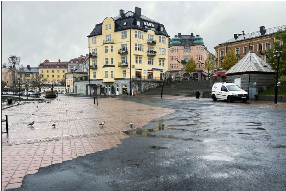
Figur 5. Marenplan efter igenläggning av schaktet. Foto från norr.
