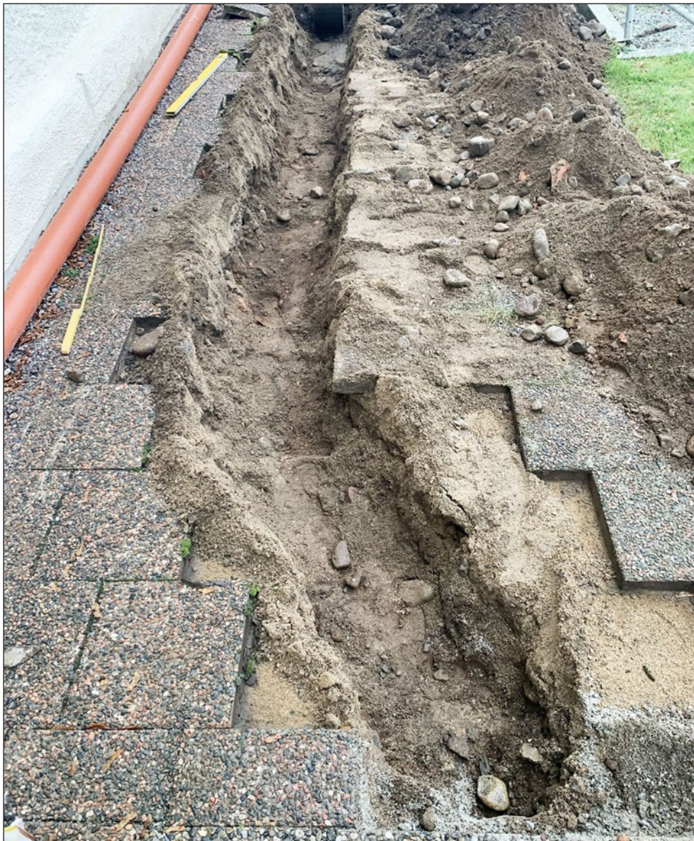
Figur 11. Schaktet söder om kyrkan. Foto från väster.
