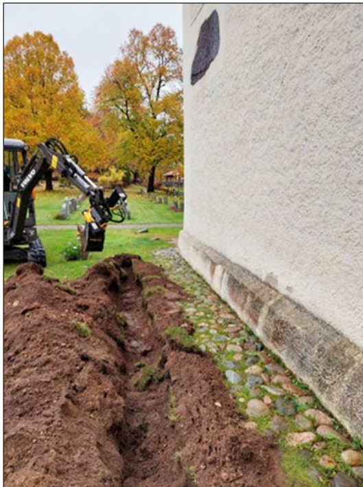
Figur 5. Schaktet väster om kyrkobyggnaden. Foto från söder.
