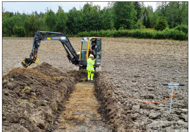
Figur 8. Inmätning av schakt S202 pågår. Till höger om schaktet ses jordsonden. Det mörka i schaktbotten är rester av lager A206.
