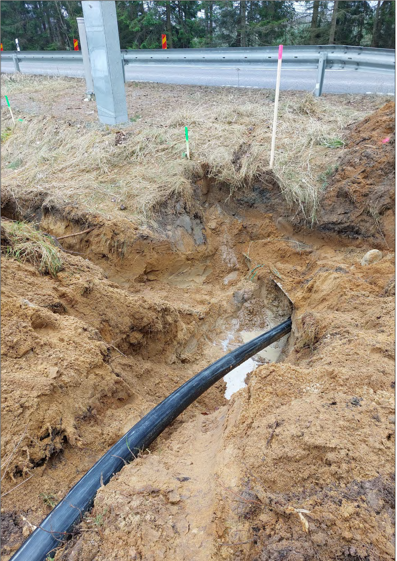
Figur 5. Schakt 1 efter att den styrda borrhningen under vägen var slutförd. Över kabeln syns den tidigare nedlagda fiberkabeln i schaktkanten. Foto från nordväst.
