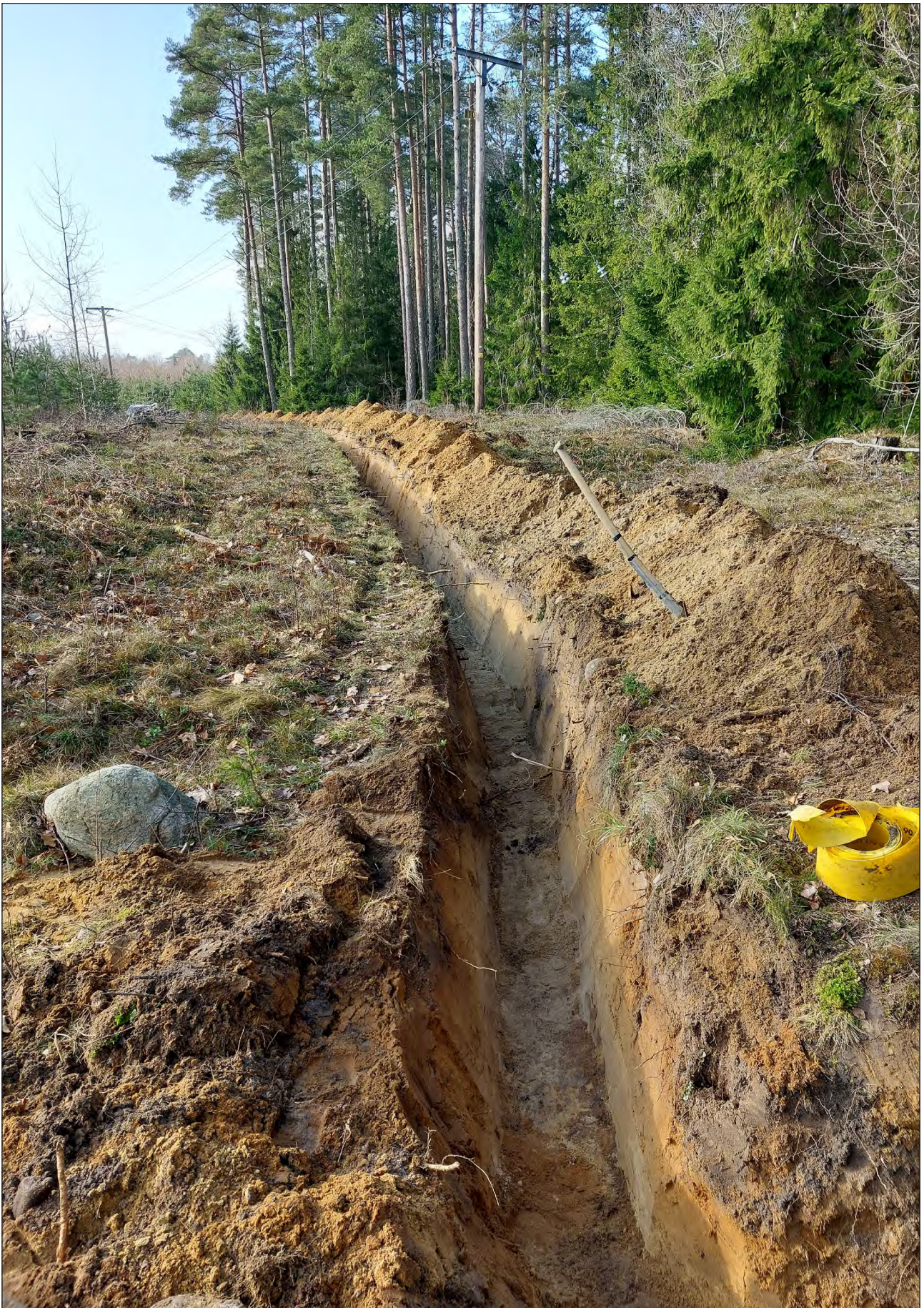
Figur 6. Schakt 2 efter färdig grävning. Foto från öster, stående bredvid kraftledningsstolpen.
