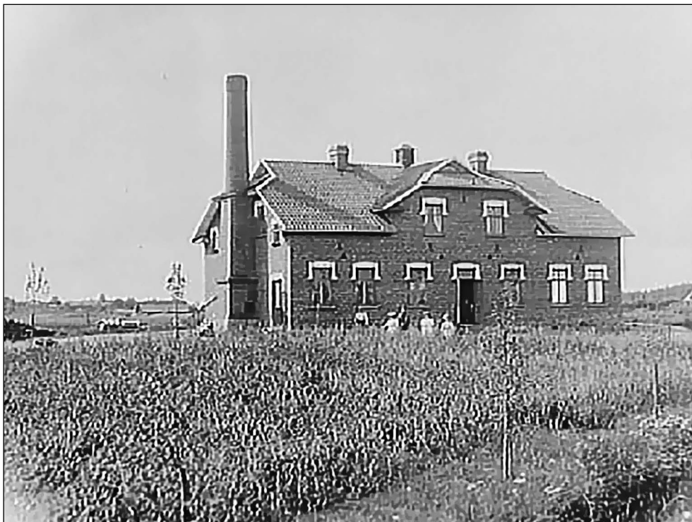
Figur 7. Stora Mellösa Mejeri, en och en halv vånings mejeribyggning med hög skorsten, tegelbyggnad, 5 personer framför mejeriet. Fotograf Samuel Lindskog. Källa: OLM-Nr.4198-1
