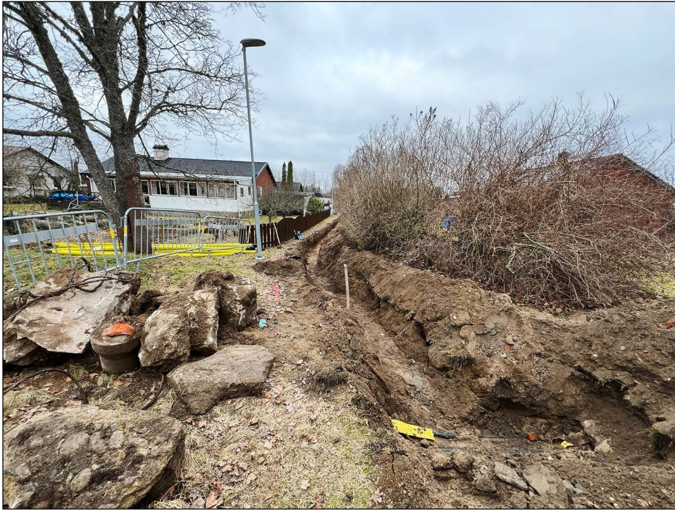
Figur 5. Schaktet är färdiggrävt och uppgrävda stenar och cementblock ligger vid sidan om. Högen L1980:4137 är gömd bakom busken. Foto från öster.
