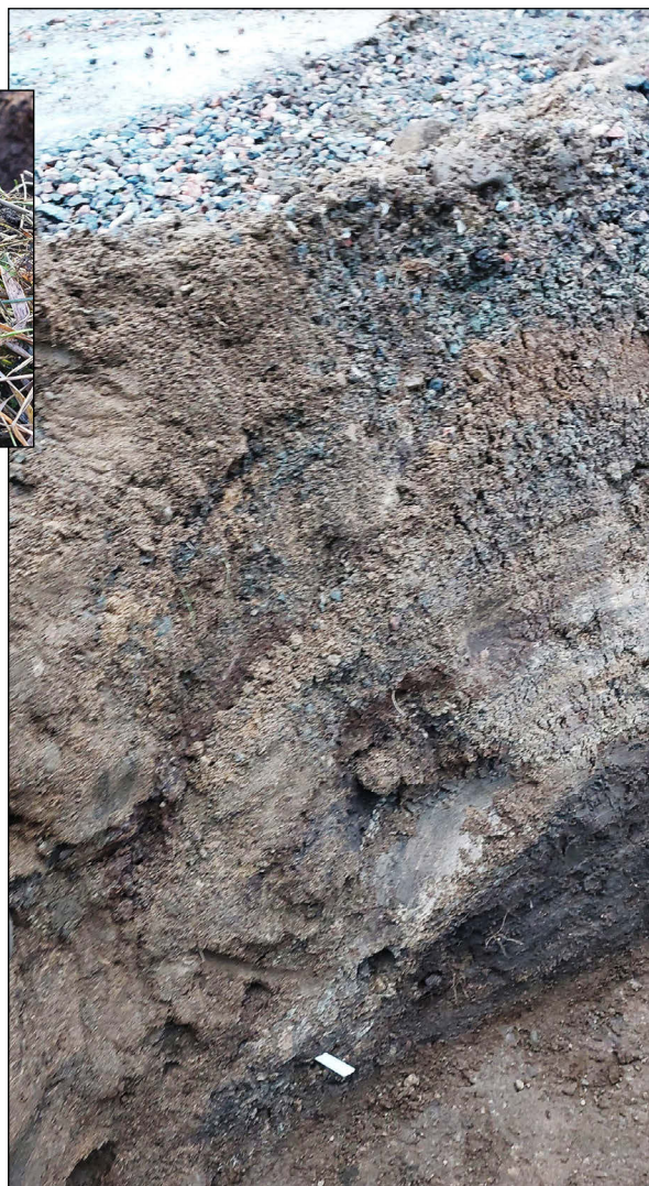
Figur 6. Olika bärlager i schaktets västra sida under den nordsydligt gående vägen med lager A1 nere till höger i bild. Foto från sydöst.
