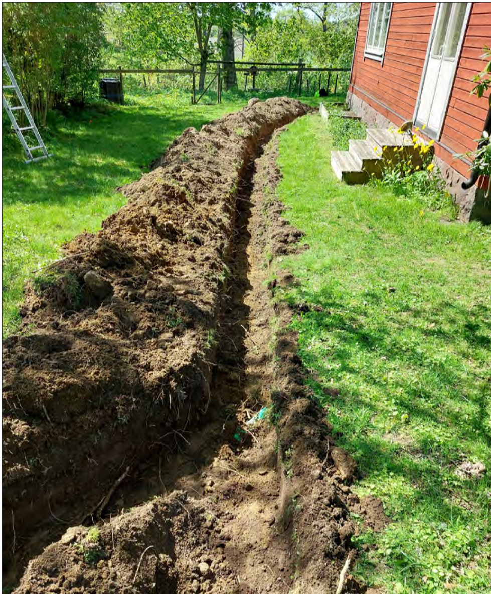
Figur 5. Schakt 2 från nordöst. Schaktet grävdes nära den befintliga bostaden.
