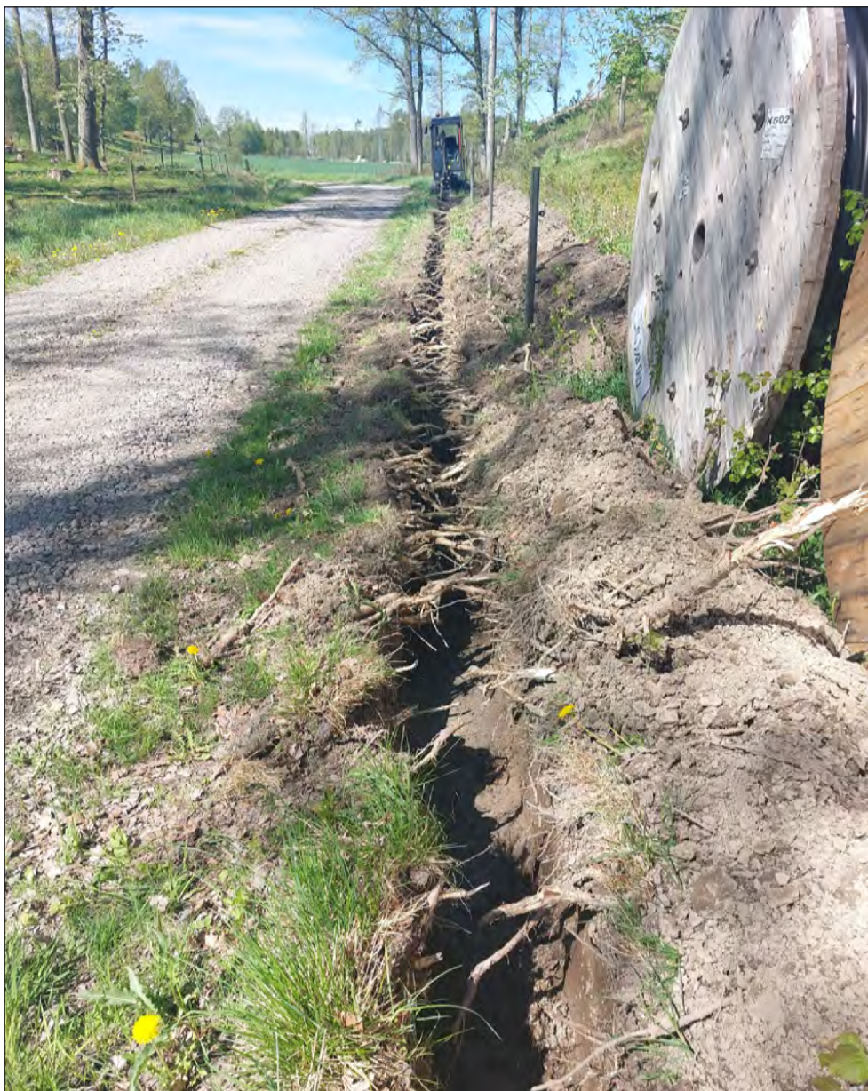
Figur 4. Schakt 1 från sydöst. Ytligt i schaktet framkom stora mängder små rötter.
