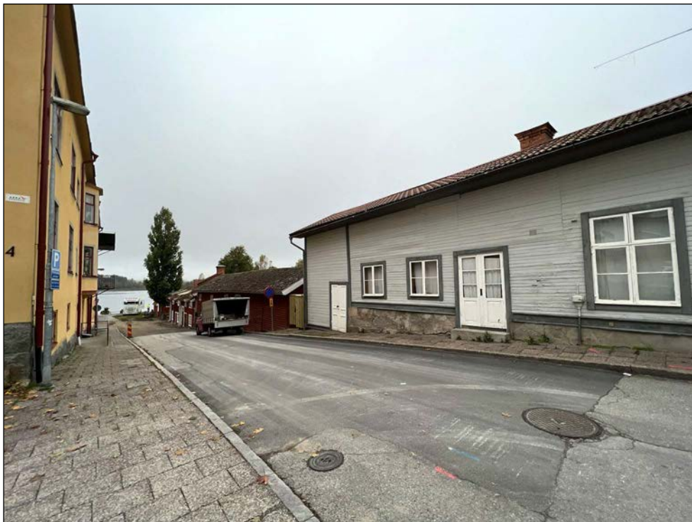
Figur 7. Platsen för schakt S4 före grävning. Foto från öster.
