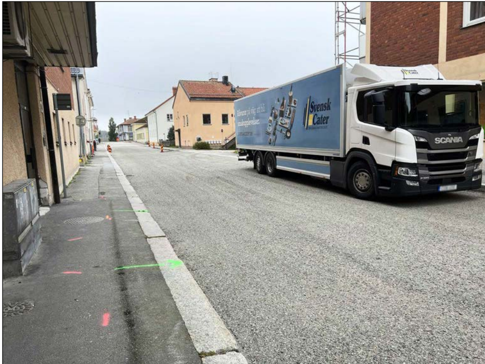
Figur 6. Platsen för schakt S1 före grävning. Foto från öster.
