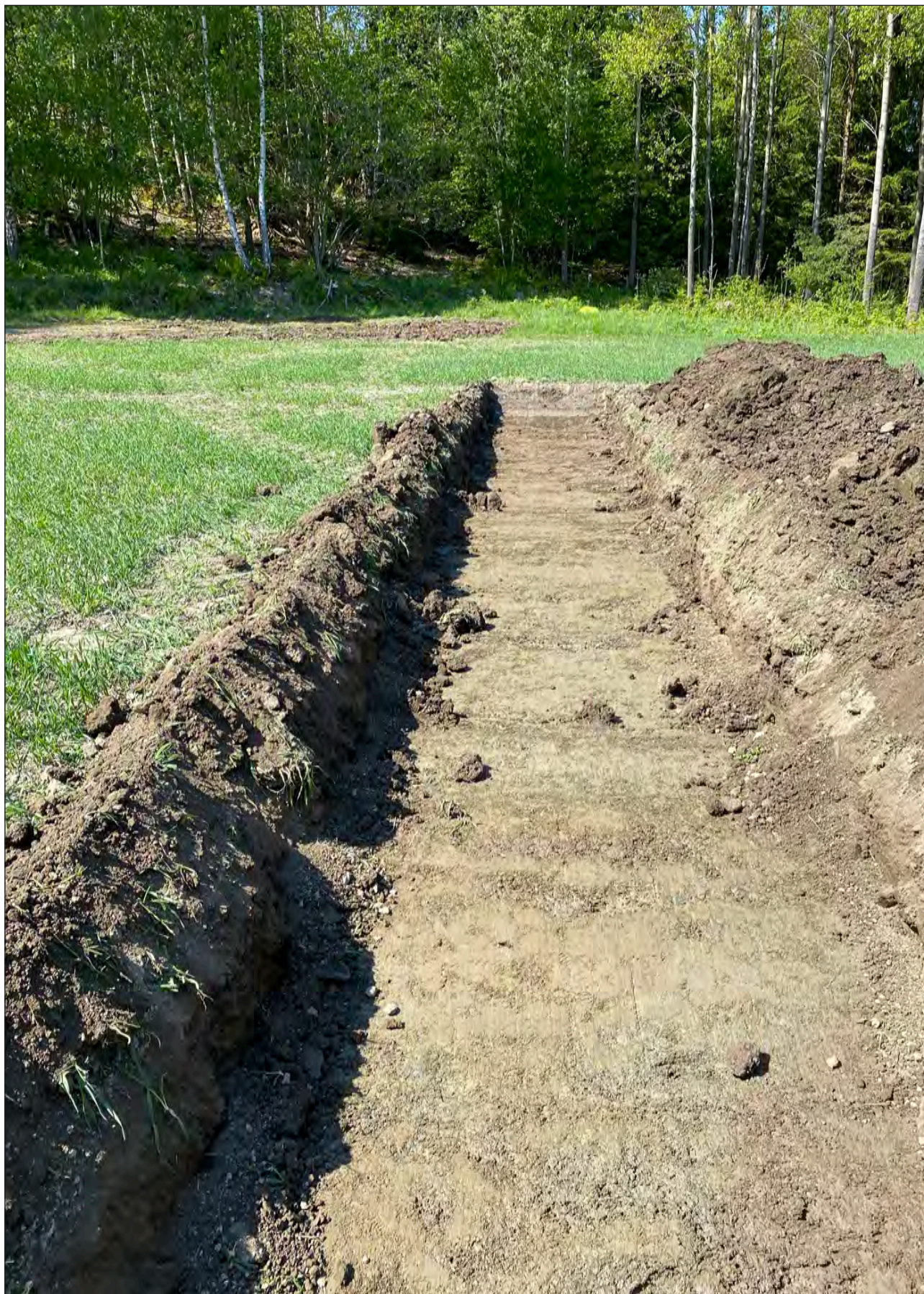
Figur 10. Schakt 133 med det igenlagda schaktet 129 i bakgrunden. Foto från sydöst.
