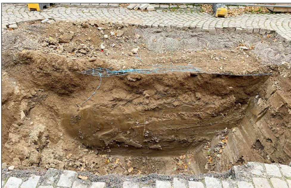
Figur 6. Schakt 3 efter slutförd schaktning. Här framkom inga ledningar. Foto från söder.
