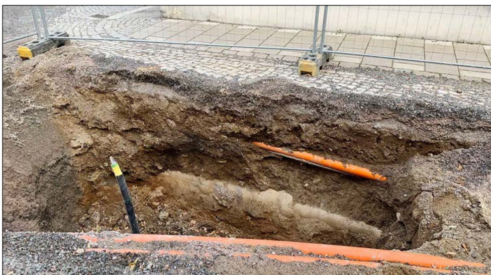
Figur 5. Schakt 1 efter slutförd schaktning. Foto från norr.
