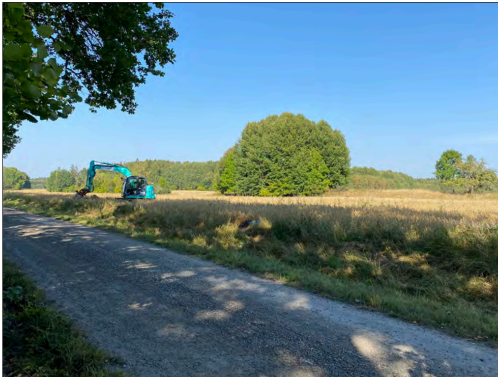
Figur 12. Igenläggning pågår i den nordligaste ytan inom objekt 6. Foto från sydväst.
