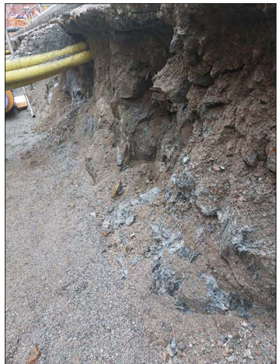
Figur 5. Den östra schaktväggen med berg synligt under fyllnadsmaterial av sand och sten. Foto från sydväst.
