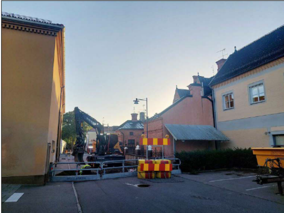
Figur 4. Schaktet tvärs över Ahllöfsgatan. Sett från nordväst.
