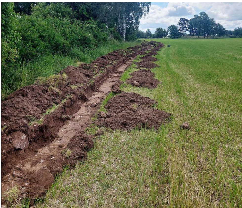
Figur 7. Schakt i delområde 2 sett från nordväst.
