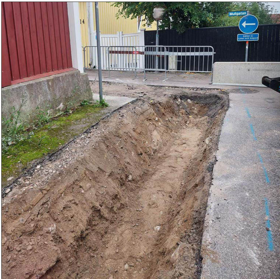
Figur 4. Korsningen Karlbergsgatan och Mullgatan. I schaktet syns fyllnadslagret och bärlagret. Foto från öster.
