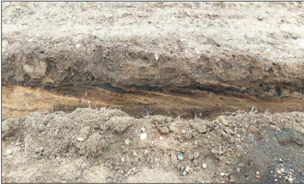
Figur 24. I schaktet påträffades också ett område med avvikande lagerbildning, A312. Här var lagren snett avsatta och mörkfärgade. Foto mot väster.
