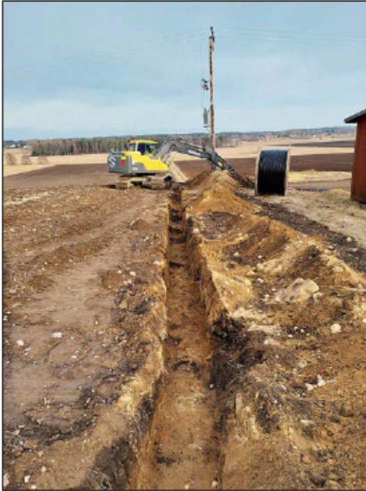
Figur 6. Undersökningsschaktets södra tredjedel. Foto mot öster.
