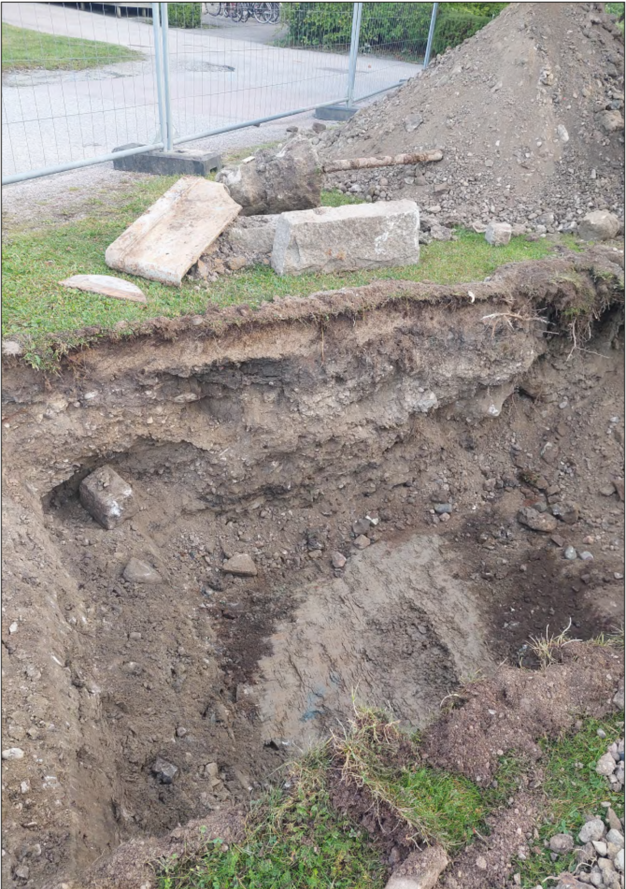
Figur 7. Schakt S125 vid schaktning. Över schaktet i bild syns modern betong som påträffades i omrörda massor i schaktet. Foto från söder.
