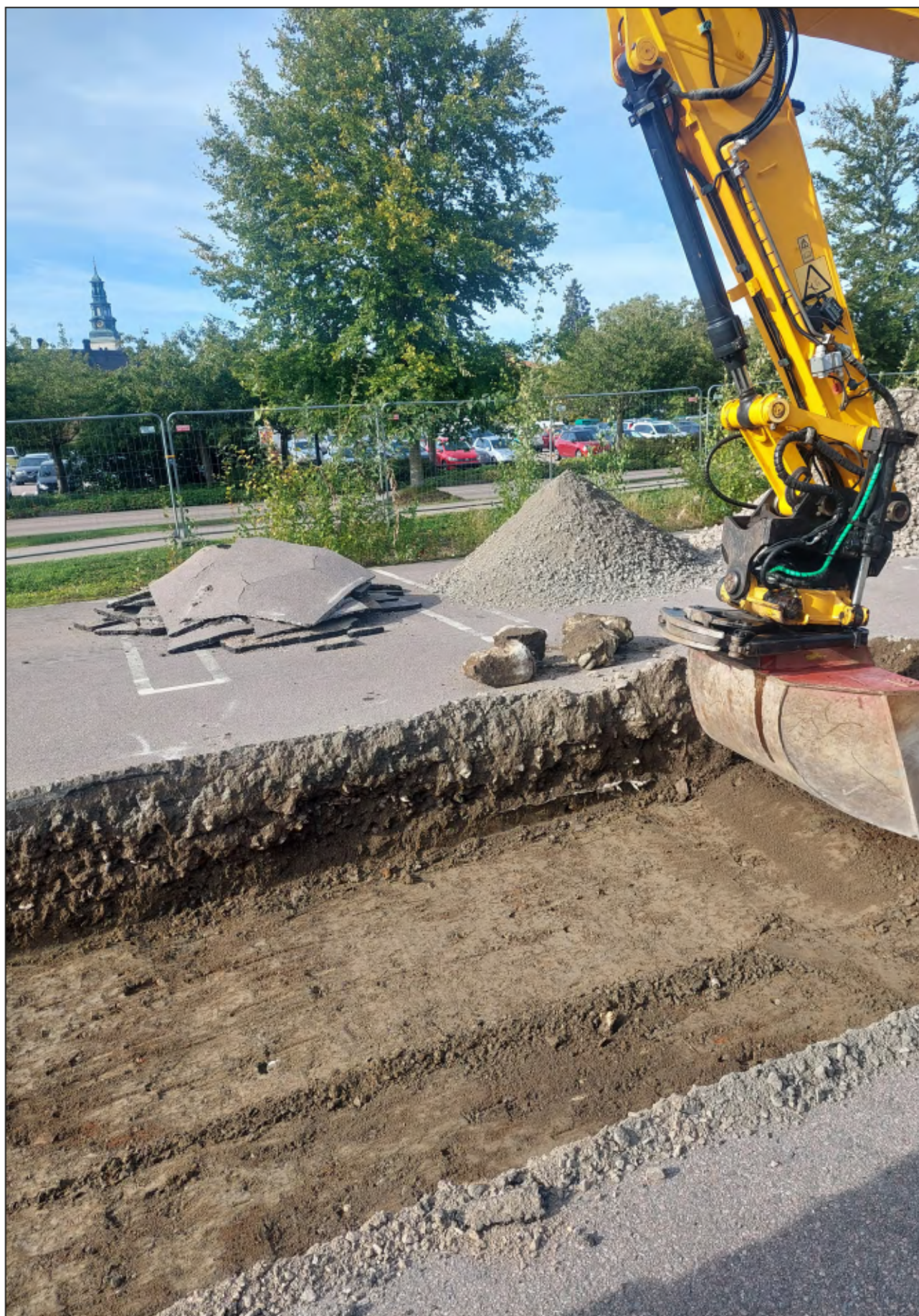
Figur 6. Schakt S100 vid schaktning. Foto från öster.
