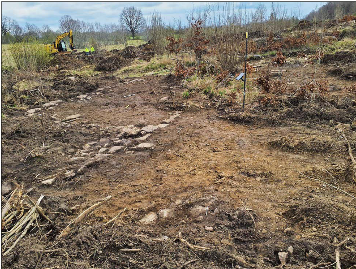
Figur 42. Schakt S1049 med stenpackning A1043 i förgrunden. Östra längan syns i bildens vänstra del. Foto från nordväst.
