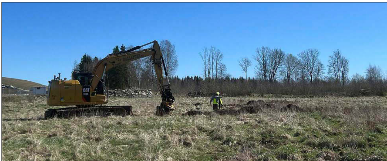
Figur 20. Schaktning i avgränsande syfte. Foto från väster.
