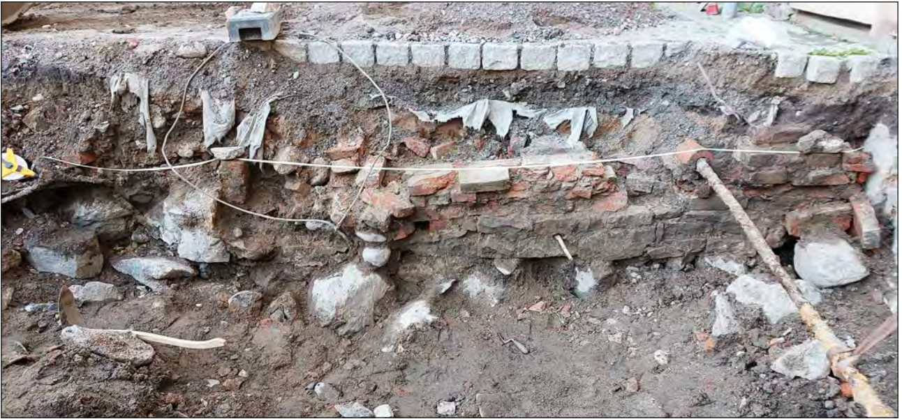
Figur 20. Mur 3 (A197) innan grävandet av den djupschaktade delen. Mur 4 (A205:1) synlig till vänster om mur 3 i bild och längst till vänster syns några av de utrasade stenarna A213, framför muren syns fyllnads-massorna som har återdeponerats på platsen efter tidigare schaktning. Foto från sydväst.
