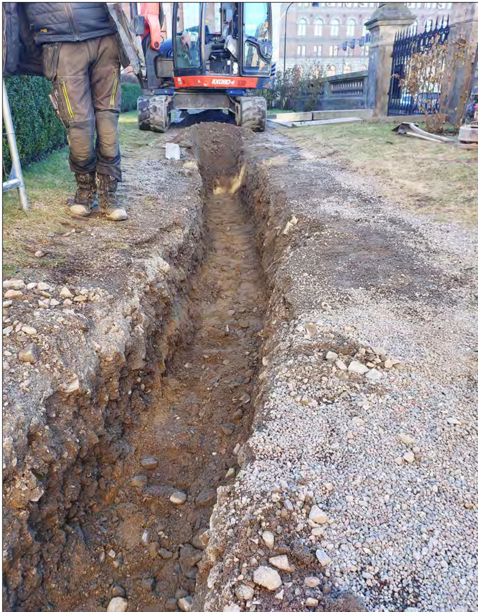
Figur 6. Grävning av schaktet vid Riddarhusparkens gräsmattas nordvästra kort-sida. I schaktet påträffades endast påförda fyllnadsmassor. Foto från nordöst.
