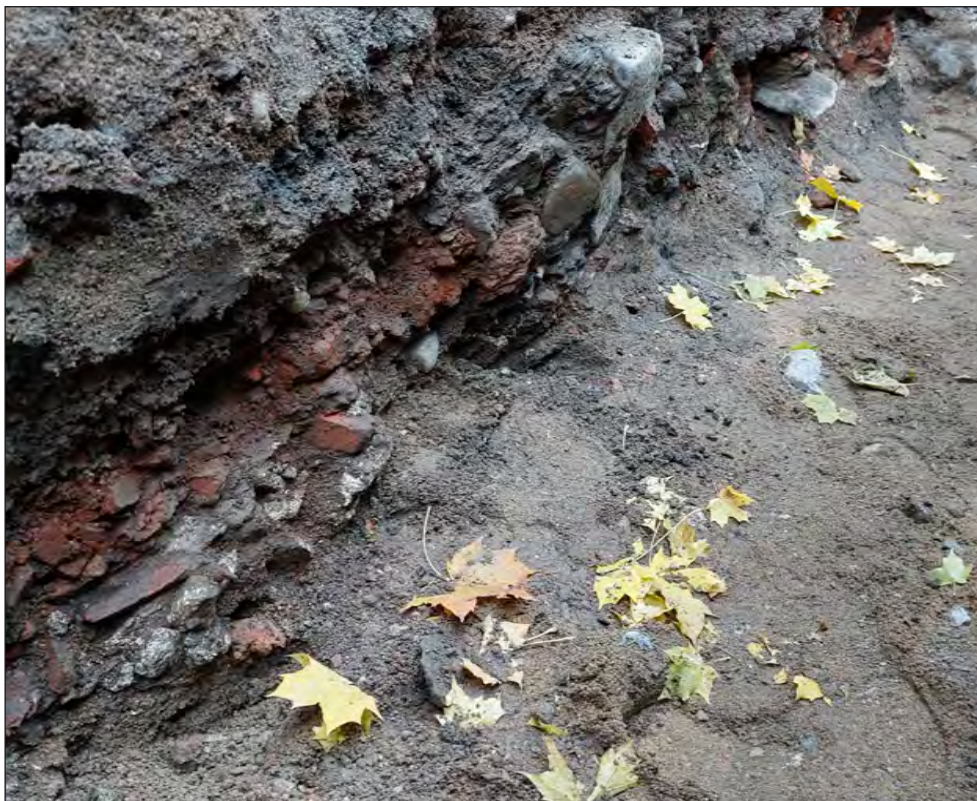
Figur 13. Muren A1 är synlig i schaktkanten. Muren är svårt skadad av tidigare markarbete. Foto från väster.
