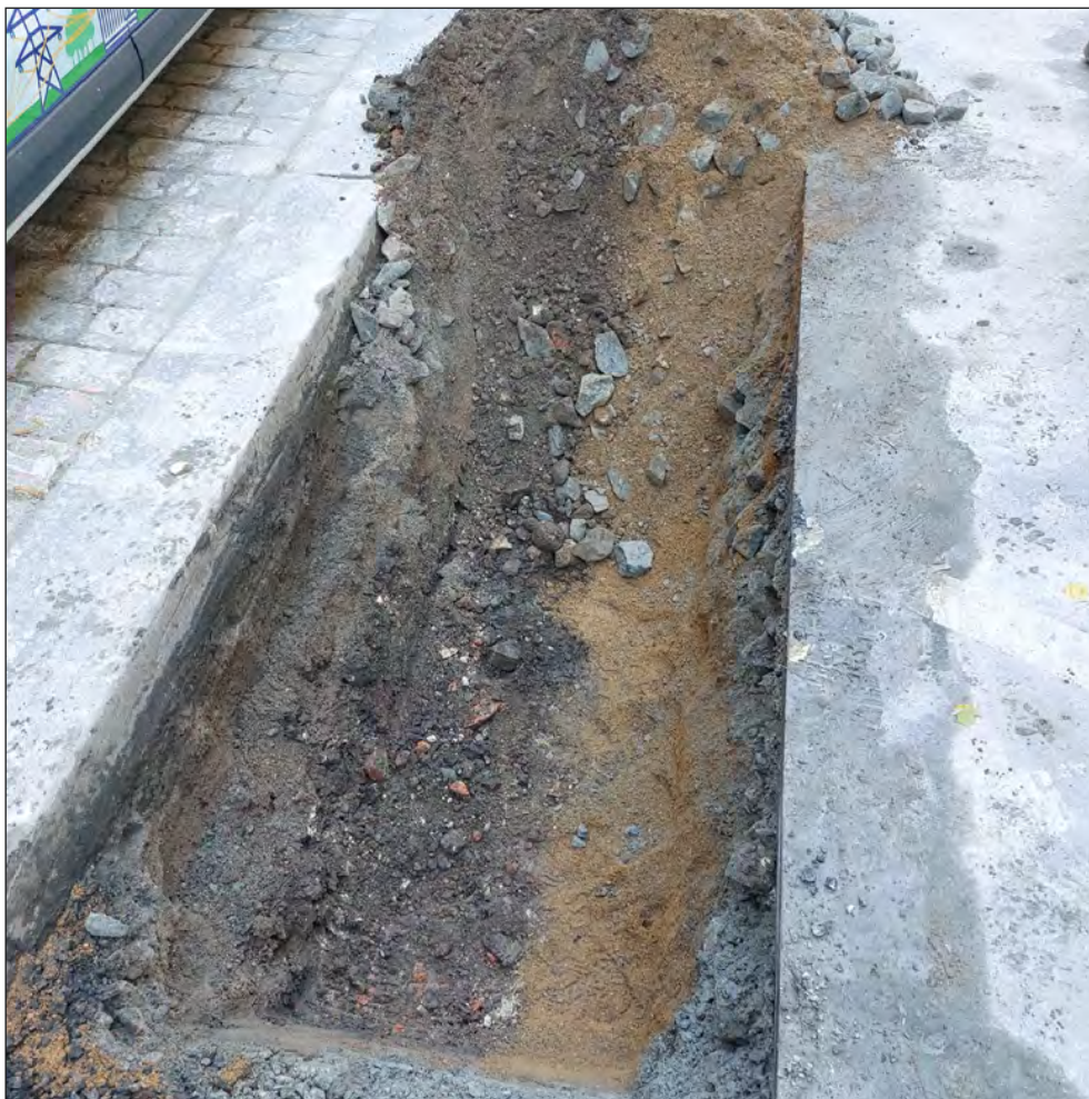
Figur 9. Det äldre fyllnadslagret har skurits av vägarbetet och nedgrävningen har fyllts med sand. Foto från nordväst.
