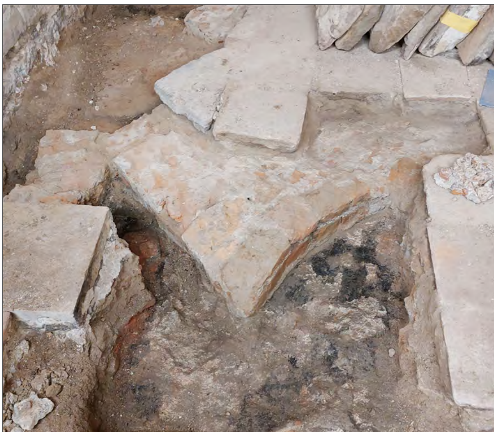
Figur 14. Tegelkonstruktionen A1 centralt i bild med A2 synlig högre i bild. Det sotiga betonglagret framme vid konstruktionen. Foto från söder.
