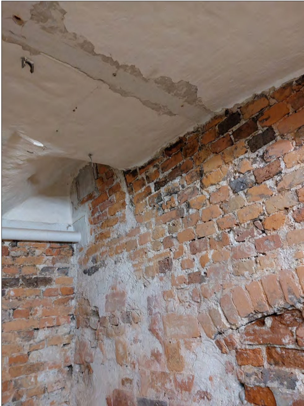
Figur 18. De igenmurade öppningarna i taket (vänster i bild) och i väggen (nere till höger i bild) direkt över konstruktionen A1 och A2. Foto från sydväst.
