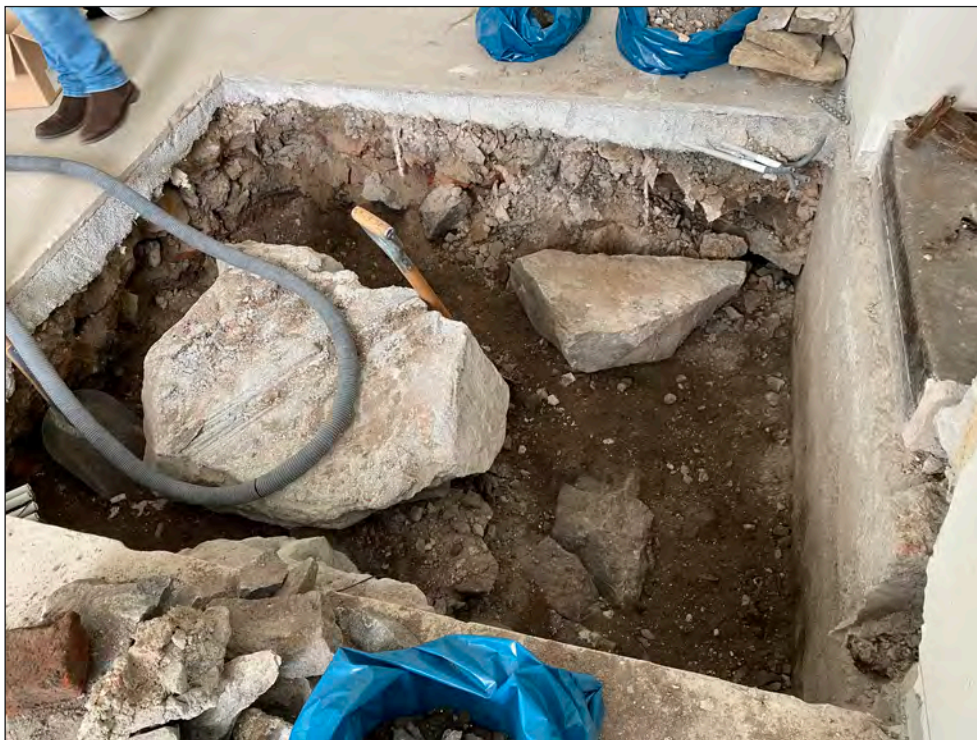
Figur 7. Schaktet S1 med den påträffade sprängstenen. Foto från söder.
