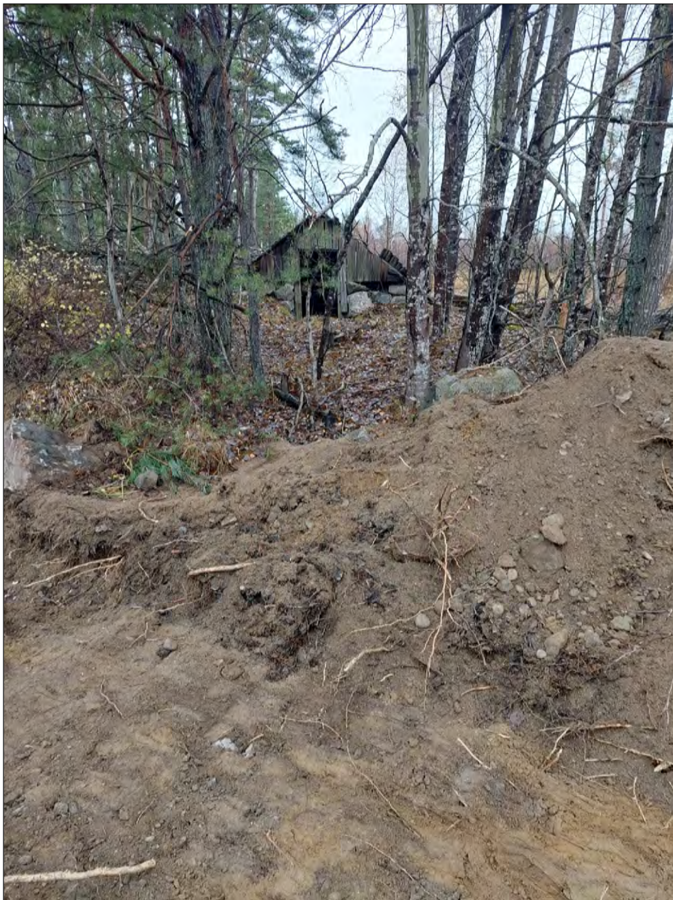
Figur 6. Schaktet längs med vägen. Foto från väster.
