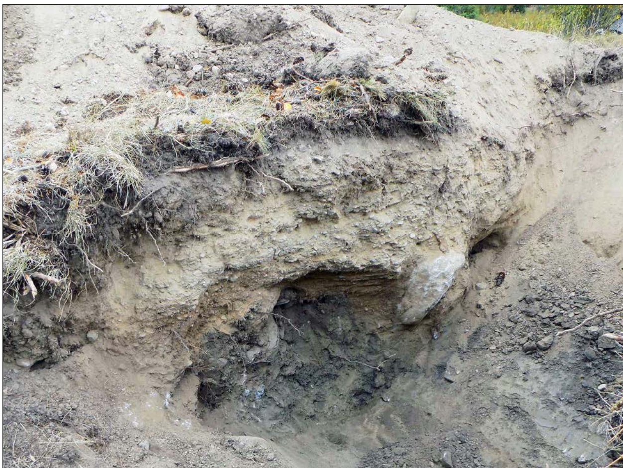
Figur 39b) Vägbank A311 under undersökning. Schaktet S1423 drogs genom bankens bredaste del, inom undersökningsområdet. Här har den en stadig lerblandad grund av sten under cirka 0,75 meter grus och småsten. I andra partier löper vägen i markhöjd. Foto från sydsydväst.
