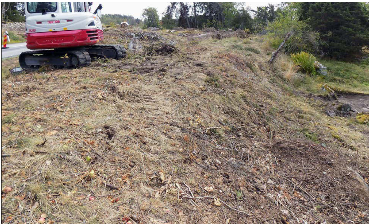
Figur 39a) Vägbanken A311 löper genom undersökningsområdets västra och östra del. I den östra, här avbildad, är den som störst, cirka 6 meter bred och 1,6 meter hög, och påverkar topografin avsevärt. Foto från väster.
