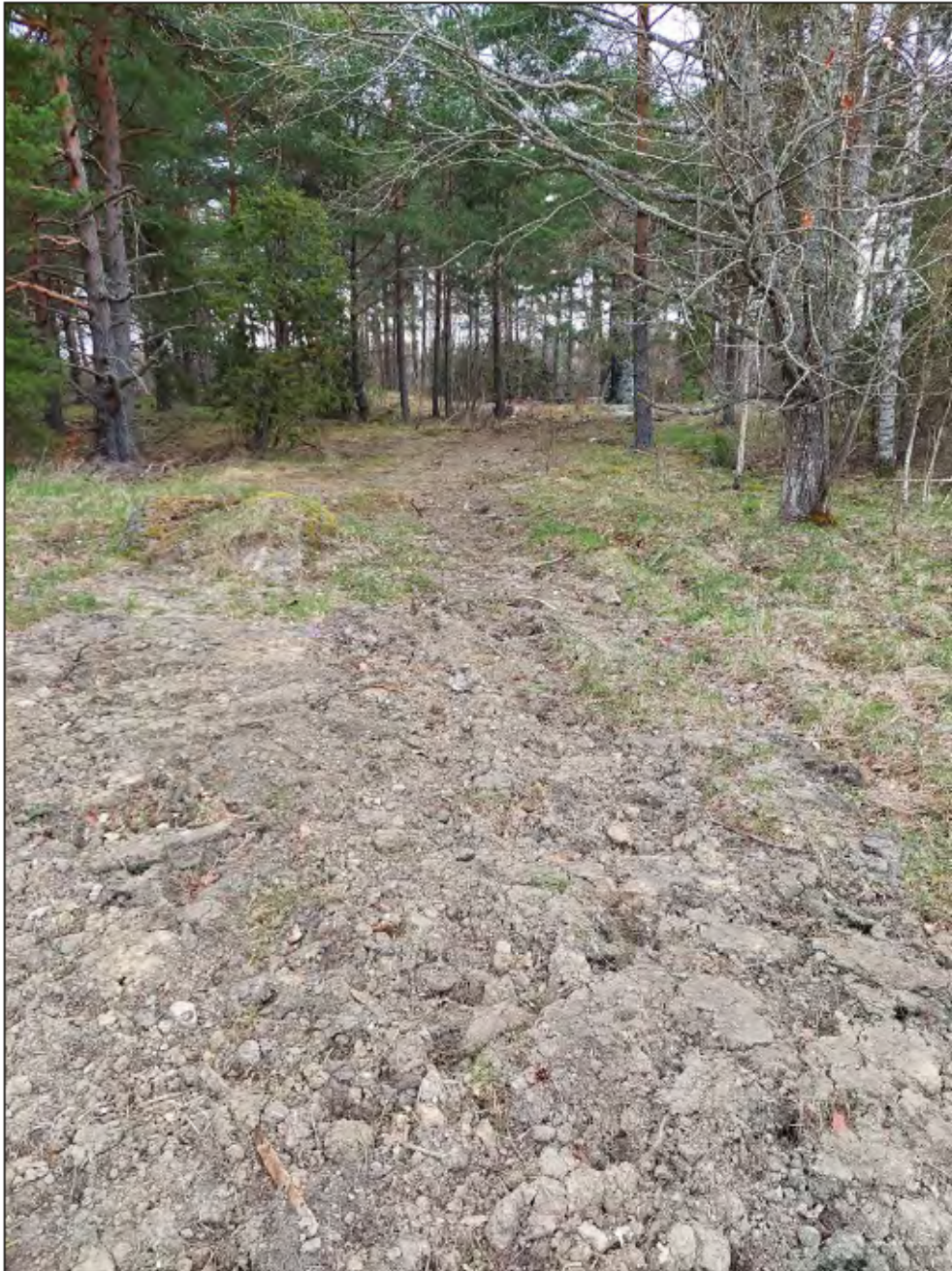
Figur 13. En del av schaktets södra sträcka efter igenläggning. Foto från sydsydväst.
