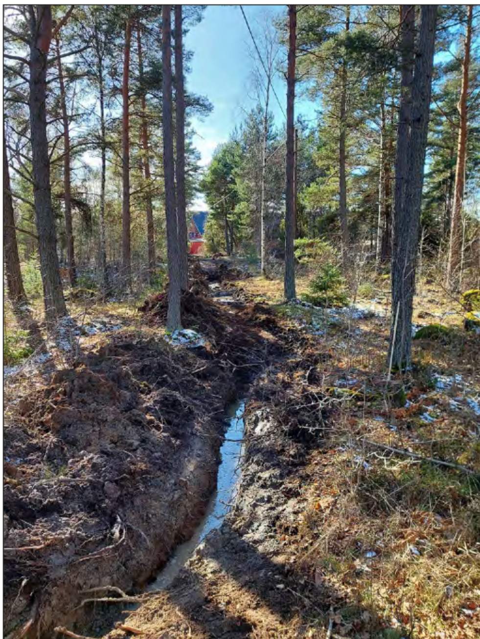
Figur 10. Schaktet betraktat från höjdryggen med den tidigare kända stensättningen L1941:5298. Foto från nordöst.
