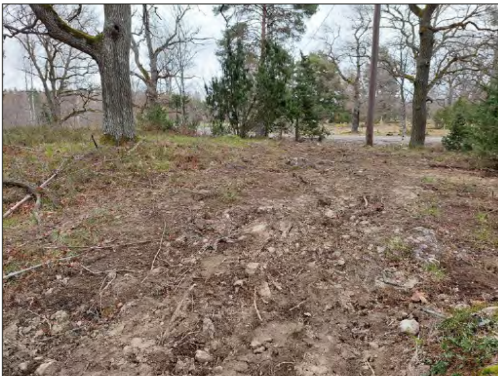
Figur 15. Delen av schaktet vilket löpte över höjdryggen med den kända stensättningen L1941:5298 efter igenläggning. Foto från sydsydväst.
