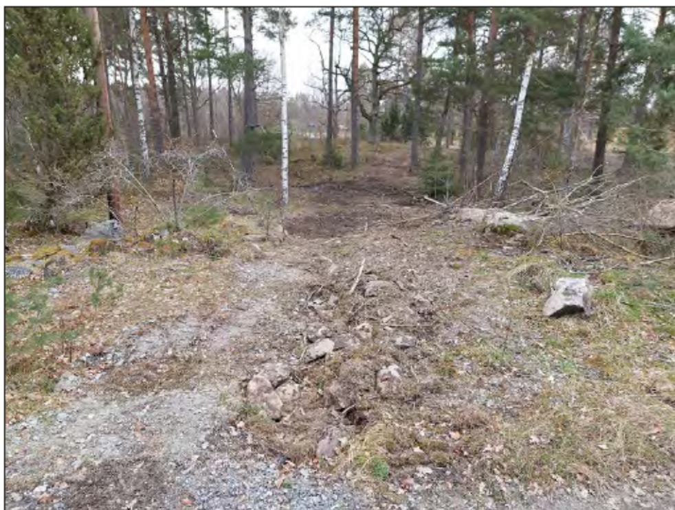
Figur 14. Schaktet som löpte över stenpackning A1 efter igenläggning. Foto från sydväst.
