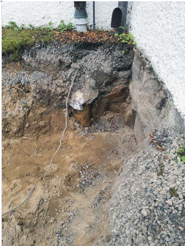
Figur 23. Gropen A100, nedgrävning intill kyrkväggen. Foto mot söder.
