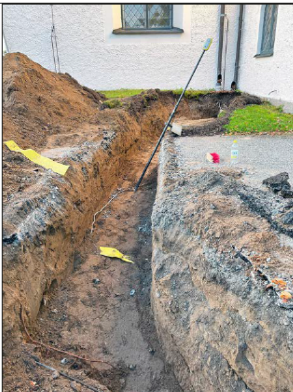
Figur 22. Schakt 204 intill kyrkan. Foto mot söder.
