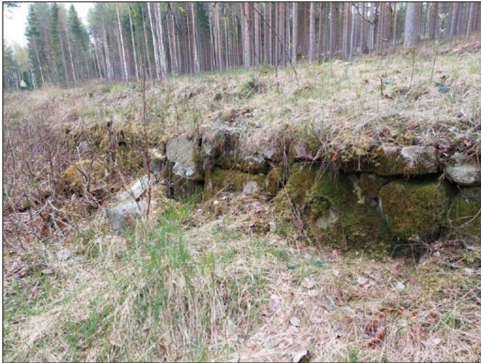
Figur 11. Utmed banvallen, Objekt 2, är långa sträckor förstärkta av kallmurade partier. De varierar från lägre, som dessa, till högre. Foto sannolikt från väst.
