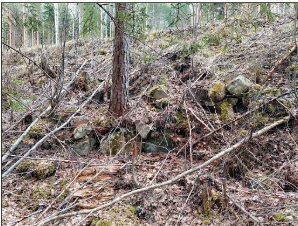
Figur 13. Även de kallmurade partierna av järnvägsbankarna, Objekt 2, är i varierande skick. Foto från nordväst.
