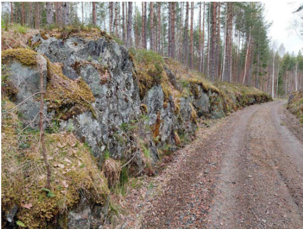
Figur 10. Närbild av det parti där barvallen, Objekt 2, sprängts ned genom berg. Foto från sydöst.
