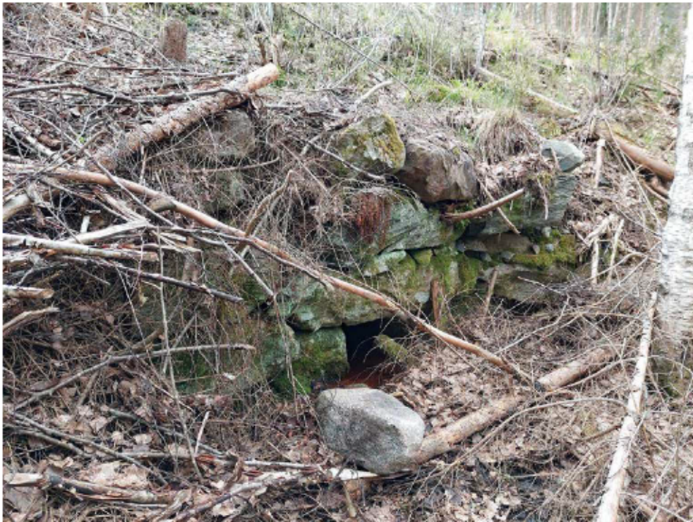
Figur 12. På flera platser har trummor konstruerats genom järnvägsbanken, Objekt 2. Dessa är i varierande skick. Foto från nordväst.
