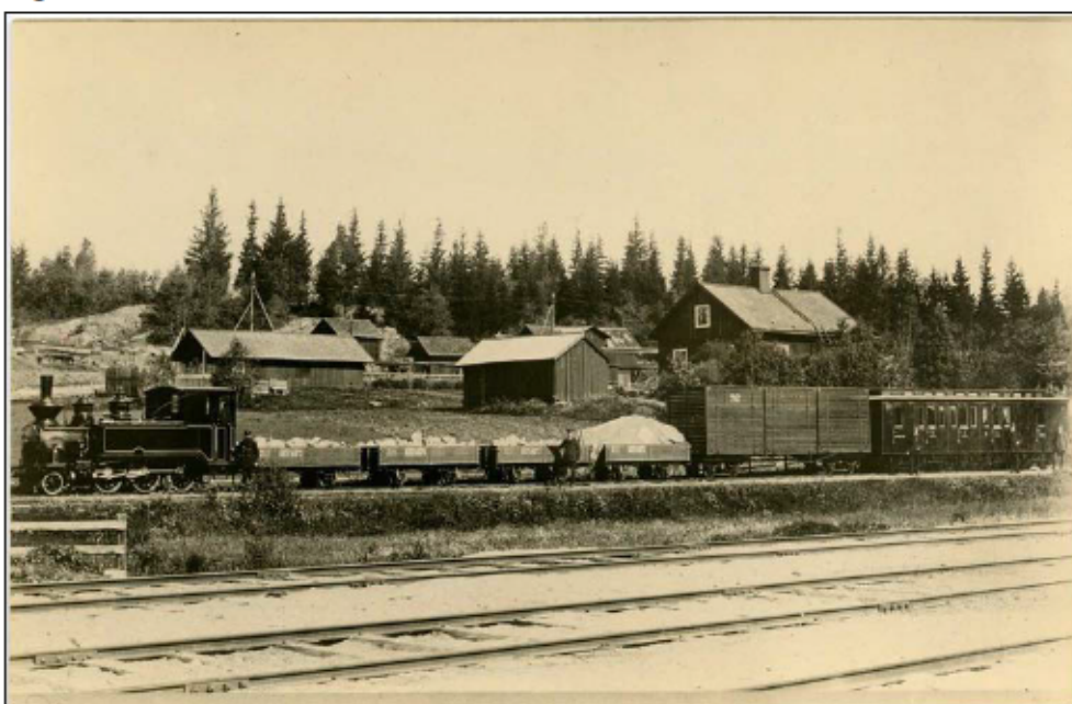
Figur 4. På den gamla omlastningsplatsen i Vikersvik korsade Wikern–Möckelns Järnvägs smalspår och Nora–Karlskogas Järnvägs normalspår. Båda järnvägarna fraktade främst malm och tackjärn. Här syns ett blandat smalspårståg med efterträdaren Bredsjö–Degerfors Järnvägs lok nr 5 omkring 1897, vid Vikersviks station. I förgrunden syns Nora-Karlskoga Järnvägs normalspår. Foto DigitalMuseum, ID JvmKDA08952, Samling: Järnvägmuseets foton.
