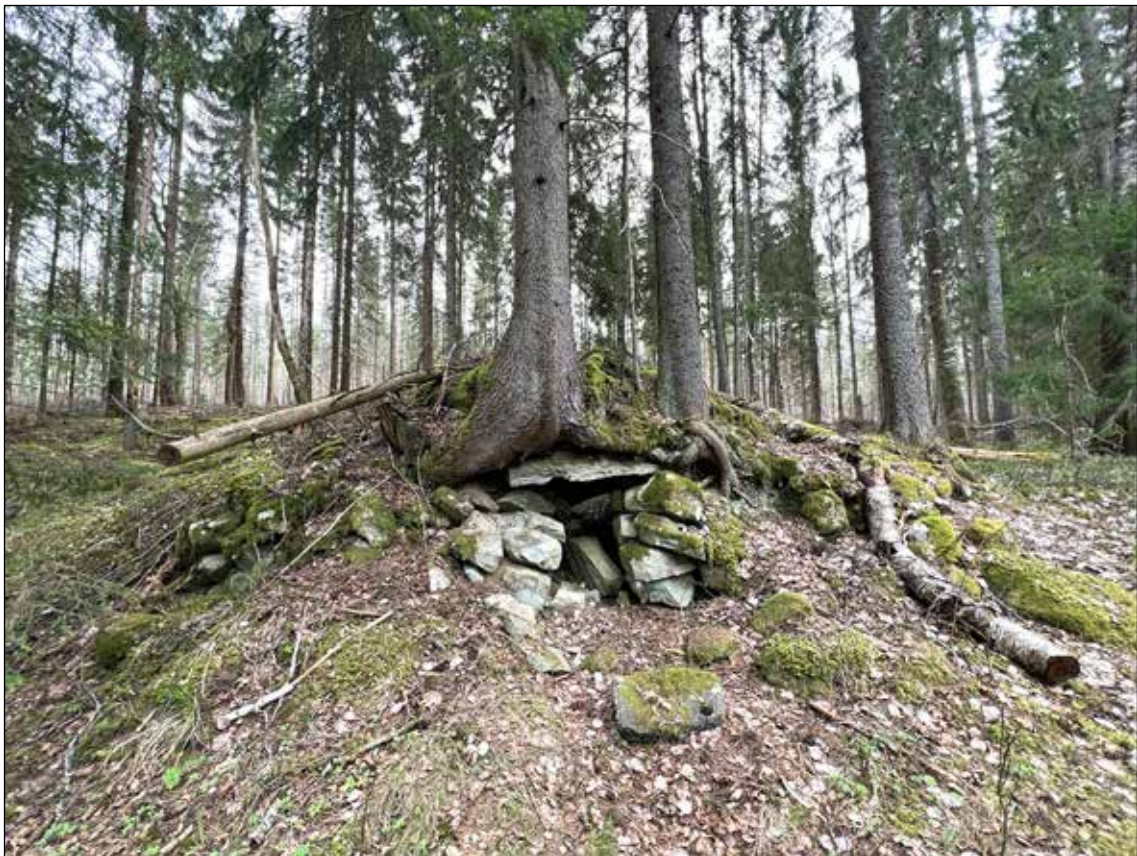
Figur 6. Källargrunden i Östra hagen. Foto från nordost.
