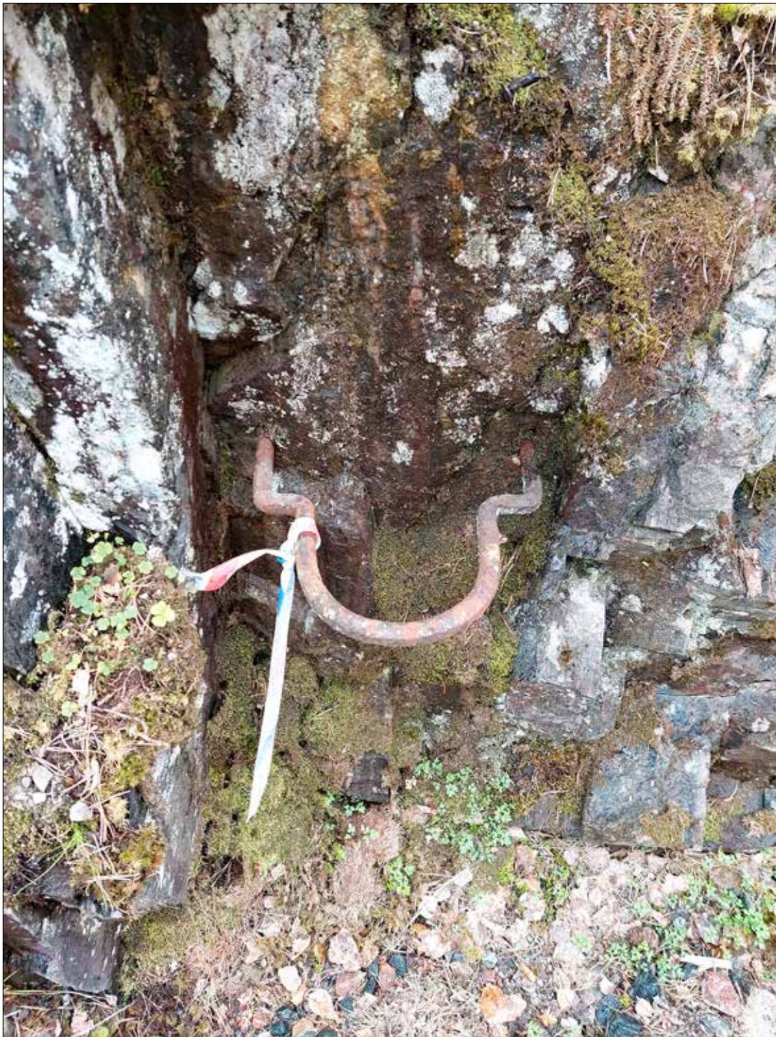
Figur 10. I utredningsområdets sydöstra del löper banvallen, Objekt 2, genom en passage där den sprängts ned genom ett parti berg. Här finns även bevarade järnkrampor, i den sydvästa kanten, vilka använts för att hålla telegrafstolpar. Foto från nordöst.
