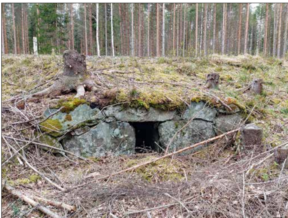
Figur 14. En bättre bevarad vattentrumma i Objekt 2. Foto från norr.
