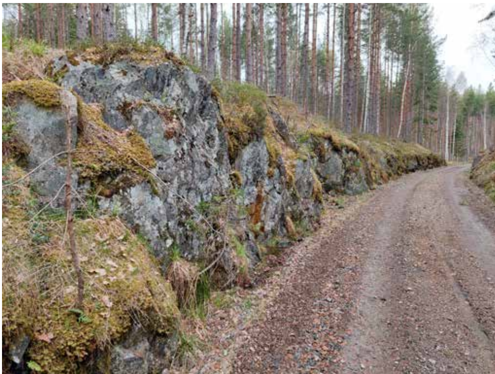
Figur 10. Närbild av det parti där banvallen, Objekt 2, sprängts ned genom berg. Foto från sydöst.
