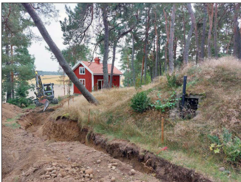
Figur 7a (överst) och 7b (nederst). Ventilationsöppning i jordkällarens norra del och östra delarna av schakten i slutet på 1970-talet respektive hösten 2024.
