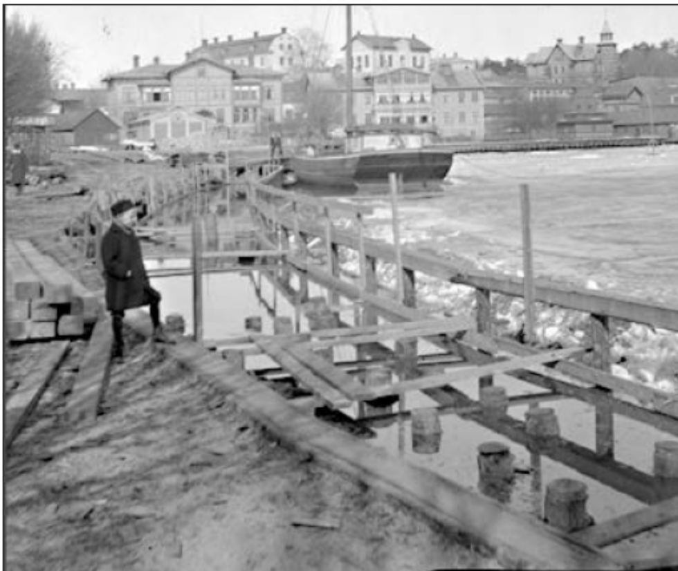
Figur 10. Om- och tillbyggnad av kajen, maj 1909. Fotograf Bernhard Lundgren, Torekällbergets museisamlingar. Bilden är beskuren.
