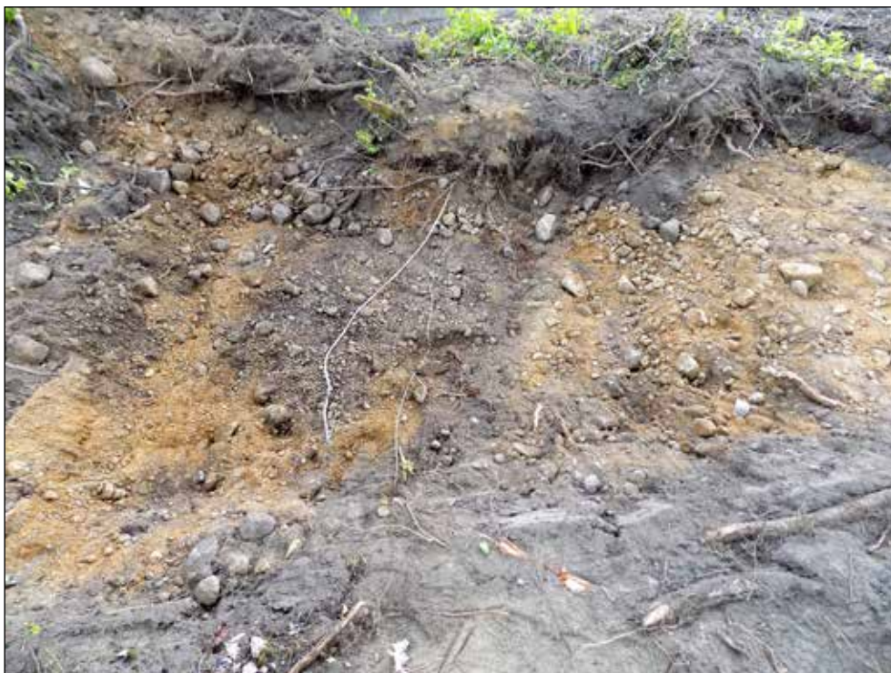
Figur 15. Översikt i schakt 290, där ledningar påträffades. Foto från öst.
