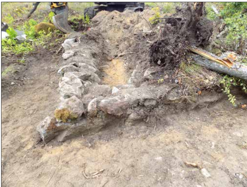
Figur 8. Foto på det schakt (S619) som togs upp utmed torpets södra och västra vägg (A634) där delar av grundmuren till Hus 1 (A100) togs fram och rensades. Foto från väst.
