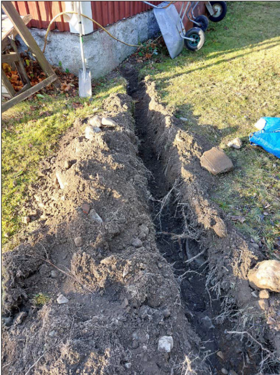
Figur 5. Arbetsbild, schaktning invid ett av de boningshus som berördes av schaktningsövervakningen. Foto från sydost.
