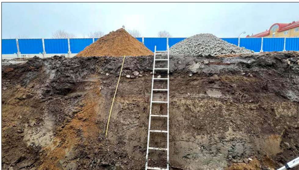
Figur 9. Stenläggningen A1 med lager L2, L3 och L4. Foto från väster.
