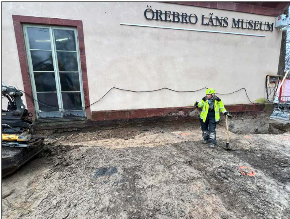
Figur 10. Ebba Knabe i schakt S3. Här har lager L6 schaktats bort och vi ser kolfläcken A10, stolphålet A7 och diket A8. Foto från norr.
